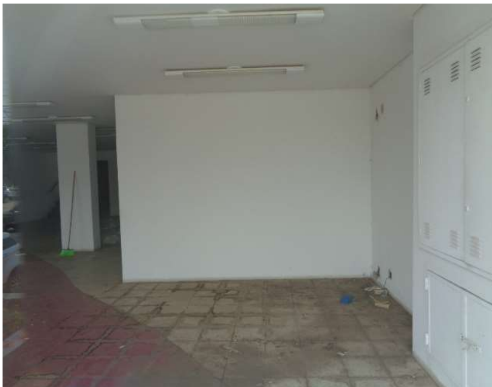
FOTO N.º 05- Vista interna do salão do pavimento térreo.
