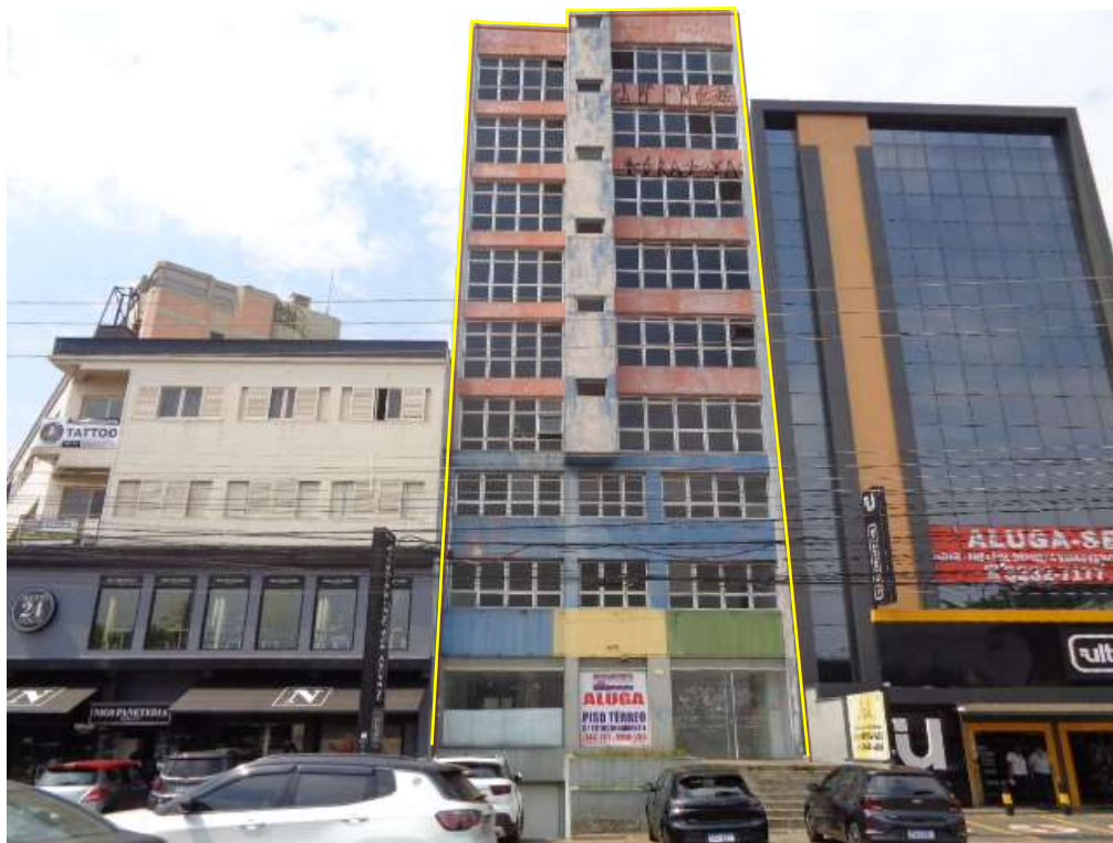
FOTO N.º 01- Aspecto da fachada do imóvel com frente para Av. Andrade Neves, n.º 2.270.
