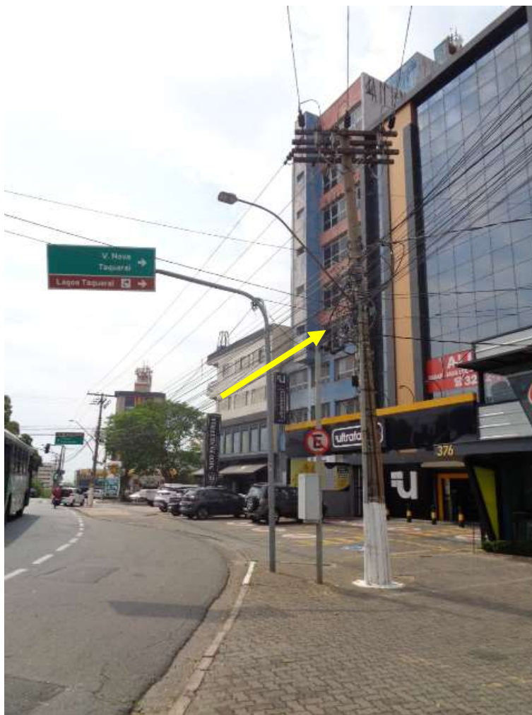
FOTO N.º 07 - Vista lateral do imóvel com frente para Av. Andrade Neves, n.º 2.270.
