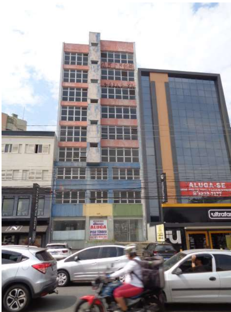
FOTO N.º 02- Tomada da fachada do imóvel com frente para Av. Andrade Neves, n.º 2.270.
