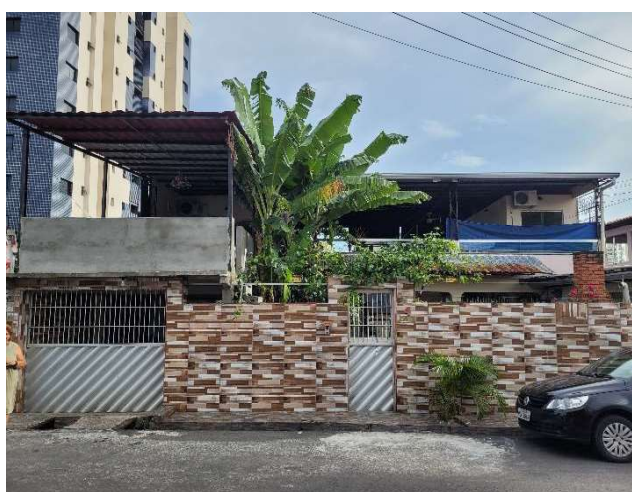
Fachada do avaliando
