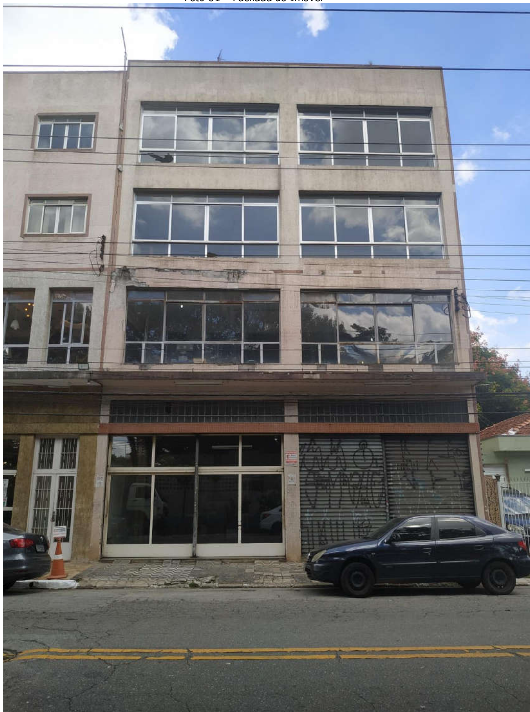
Foto 01 – Fachada do Imóvel
