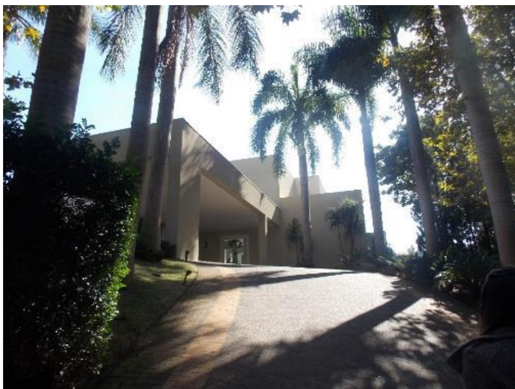
Foto nº 13 – Rampa de acesso – Vista do imóvel.
