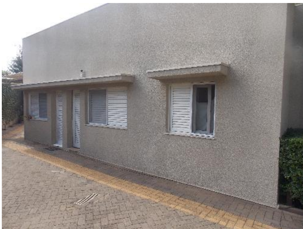
Foto nº 97 – Casa do Caseiro.
