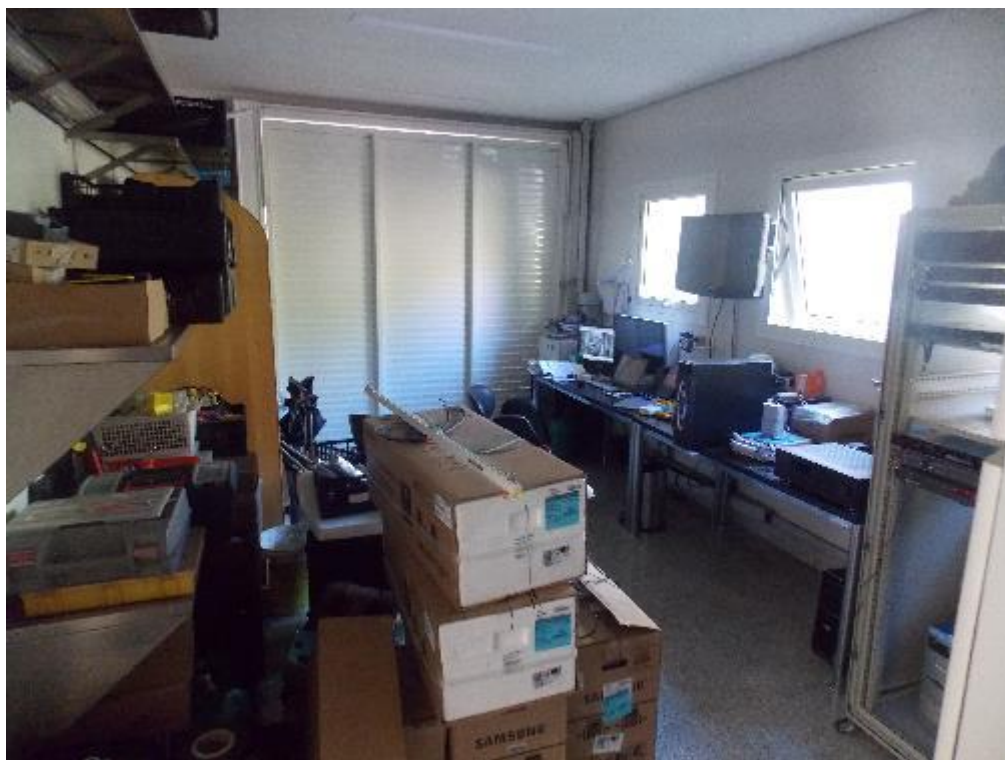
Foto nº 78 – Sala de Monitoramento.
