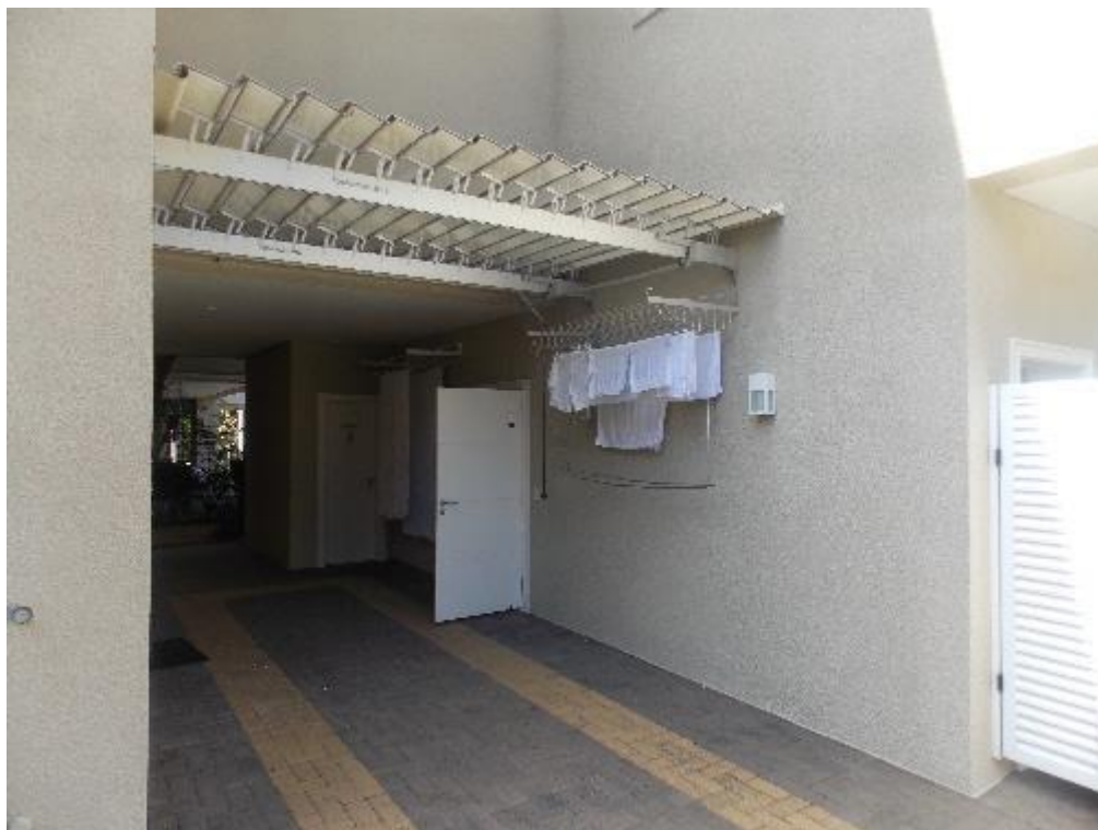
Foto nº 76 – Acesso a casa de bombas e Sala de Monitoramento.
