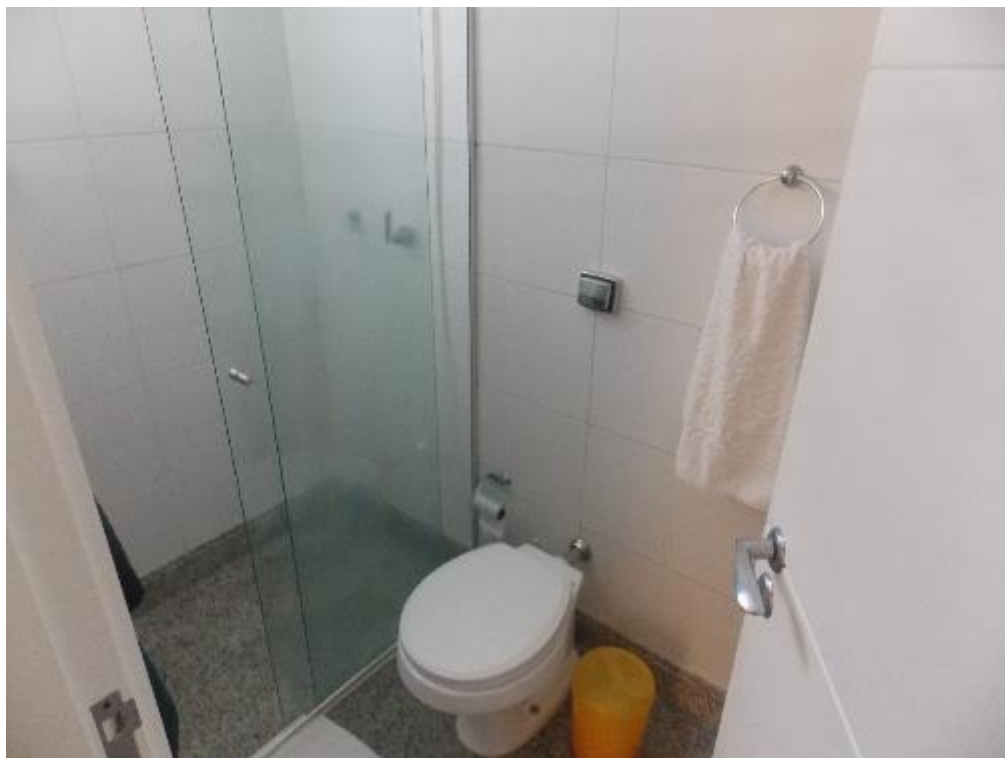
Foto nº 38 – WC de Empregada
