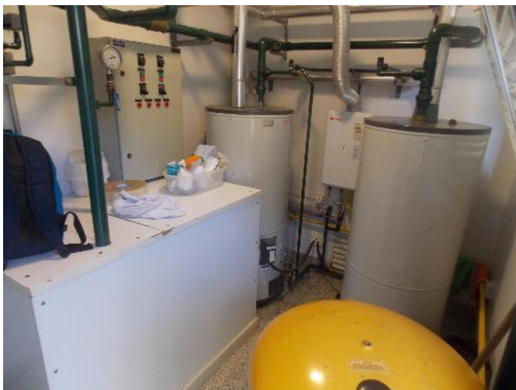
Foto nº 79 – Casa de Bombas.
