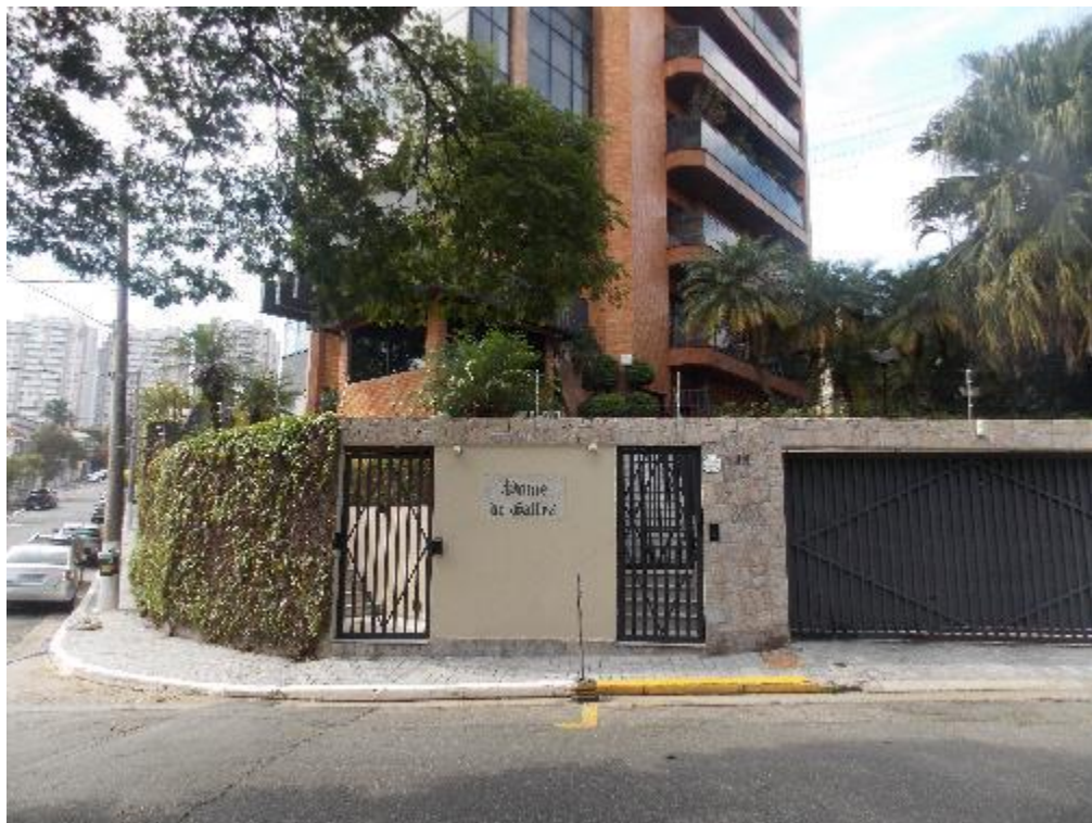
Foto nº 1 – Fachada frontal do imóvel.
