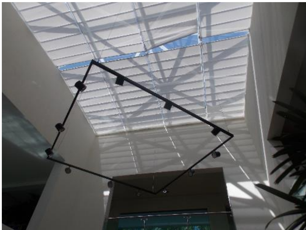
Foto nº 24 – Cobertura de Vidro da Sala de estar.
