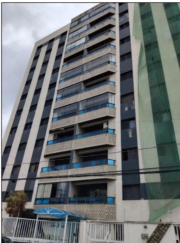
Fachada do Edifício San Marino
