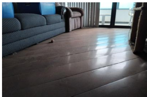
Piso de madeira
