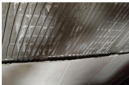
Detalhe parede banheiro
