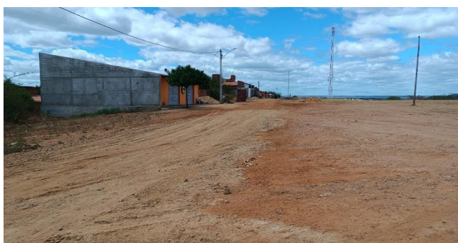
Foto 8 - Foto retirada na posição 06 - Qd 05 Lts 01 a 13
