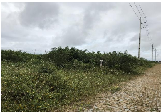
Foto 19 - Vegetação impede o acesso interno aos lotes
