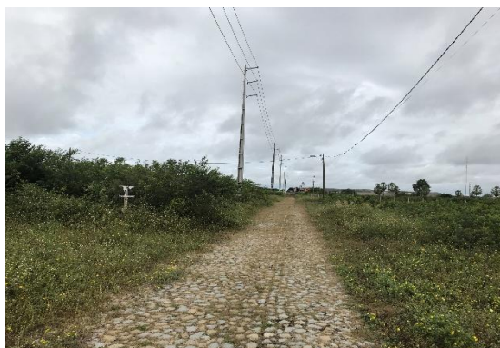
Foto 7 - Via frontal aos lotes avaliandos
