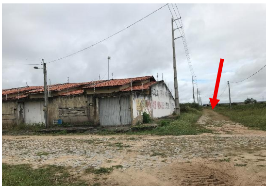
Foto 23 - Seta identificando a via em frente aos lotes avaliados
