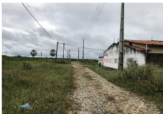
Foto 22 - Estado da via que passa em frente aos lotes avaliados
