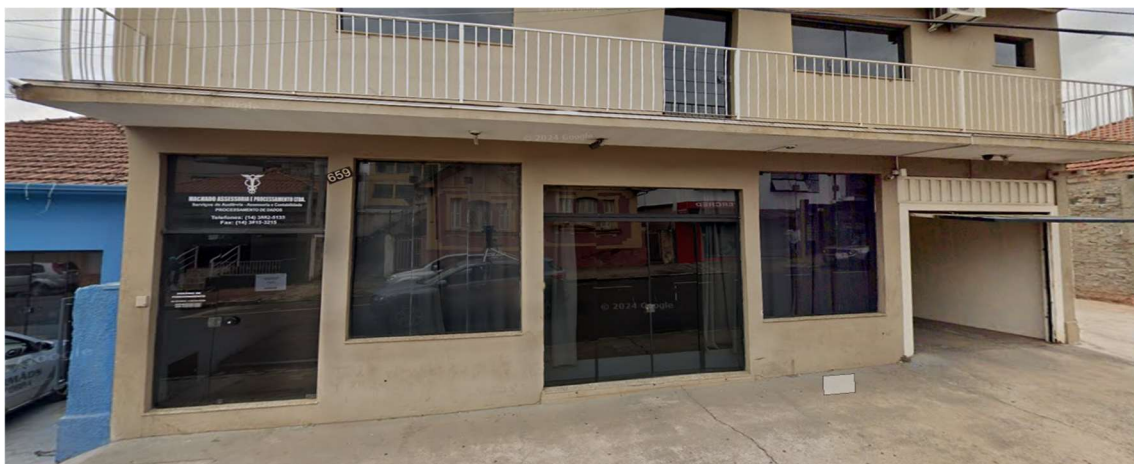
Figura 1 - Fachada do imóvel
