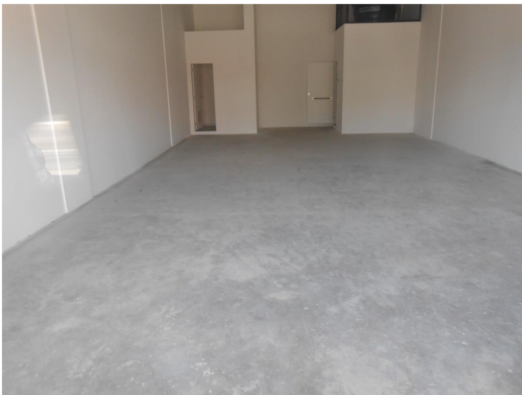
Foto 7: Piso do imóvel avaliando
