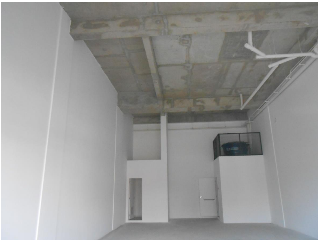
Foto 8: Teto do imóvel avaliando
