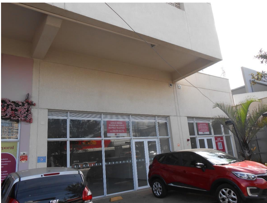
Foto 4: Fachada do imóvel avaliando
