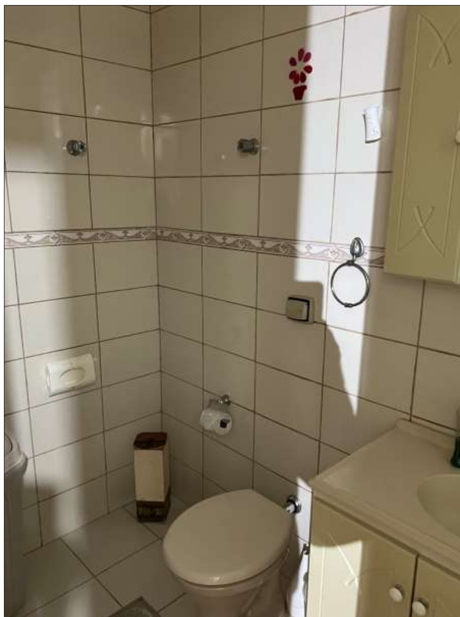
O banheiro social.
