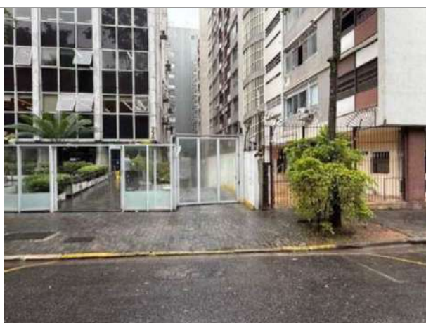
Entrada de veículos
