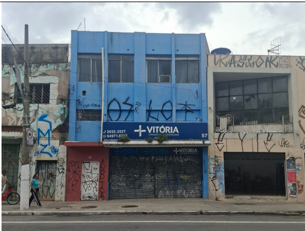
Fotografia 1 – Fachada do Prédio
