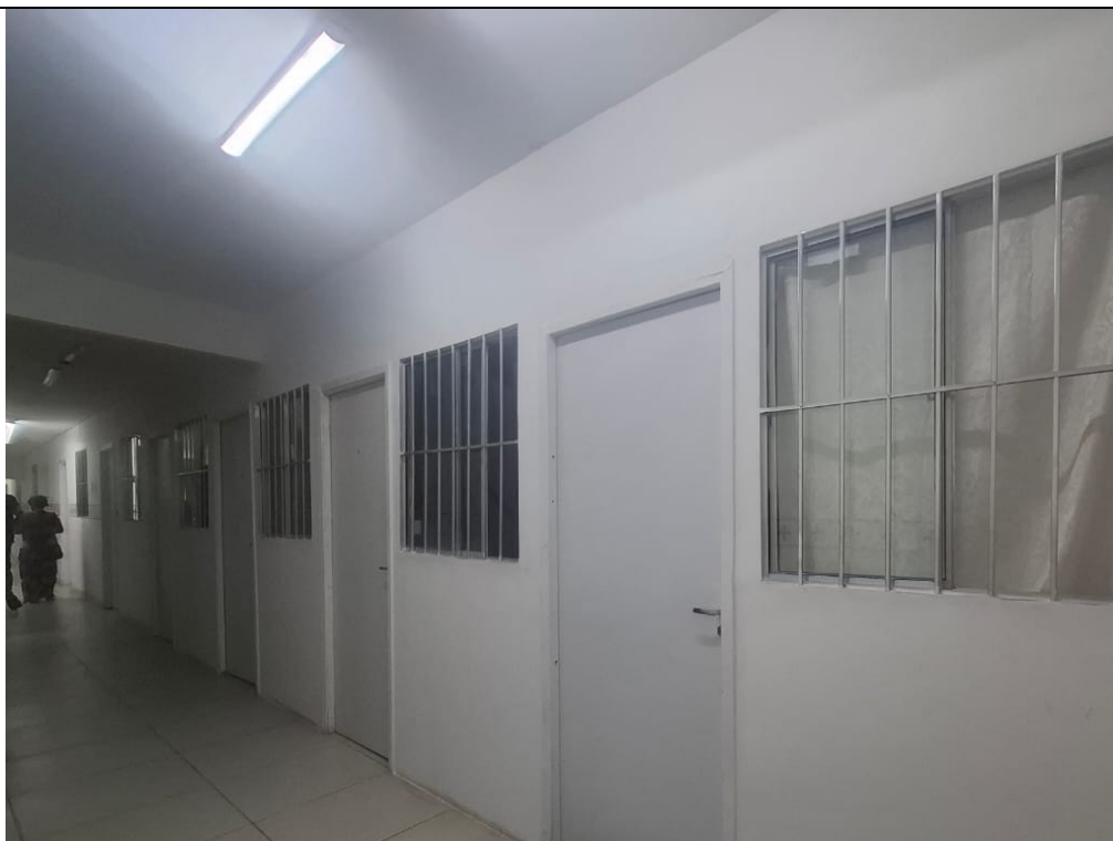
Fotografia 3 – Salão Comercial c/ boxes de atendimento em drywall (Térreo)
