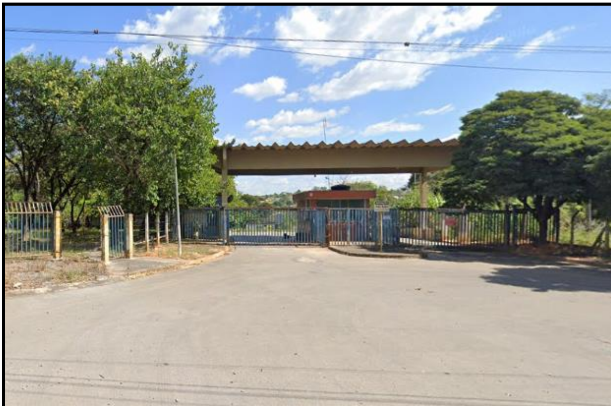
FOTO 01: Entrada do imóvel.
