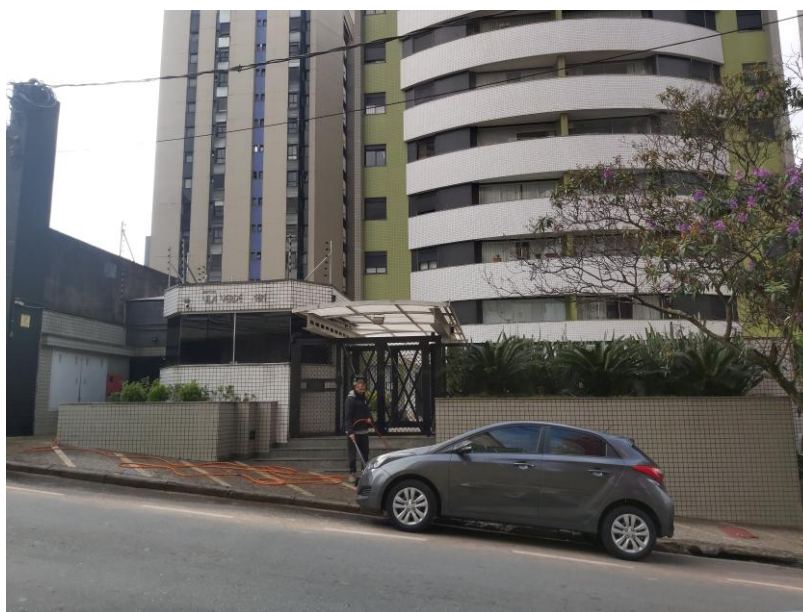
Vista do Edifício Vila Verde onde está localizada a vaga de garagem nº 54
