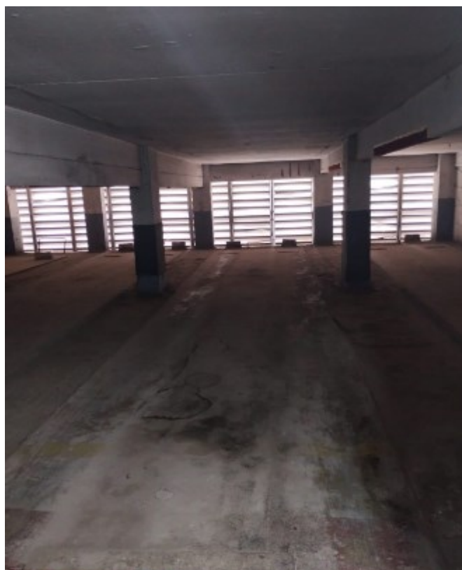
Foto 03 Vista da parcial Box da Garagem
