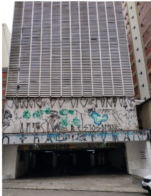
Foto 01 Vista da fachada da Garagem
