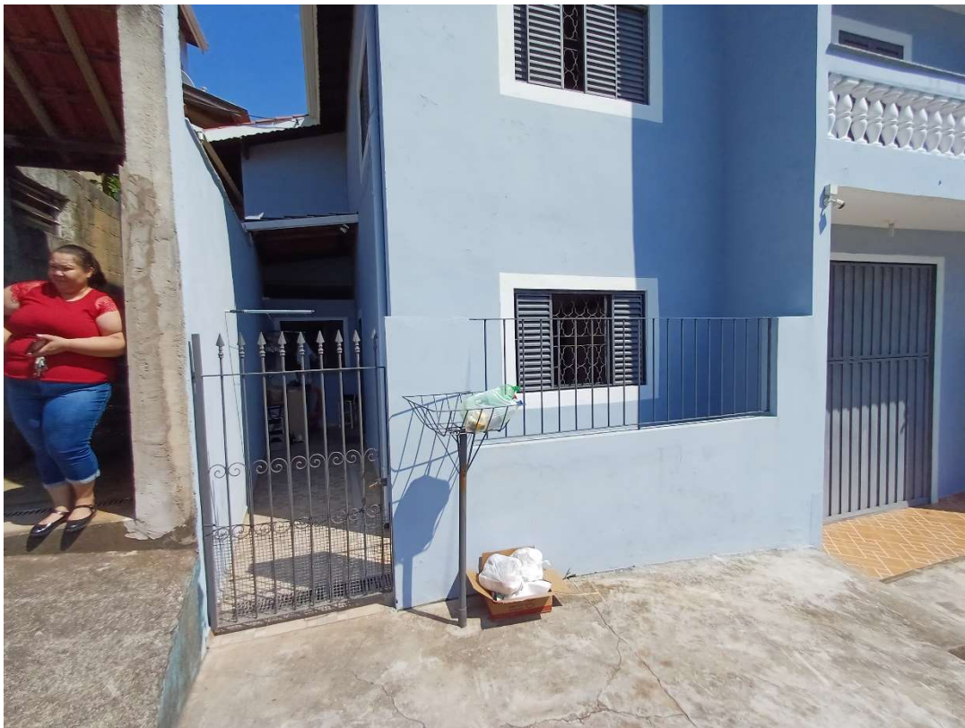
Foto 22: Fachada da Residência 2. Não foi possível acessar o interior do imóvel.
