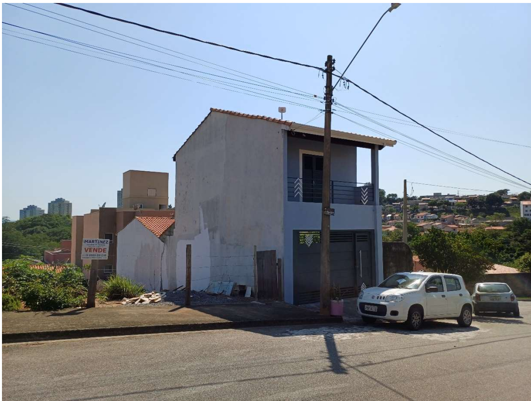
Foto 3: Imóvel visto a partir da Avenida Ainda Haddad Jafet, sendo visível a entrada da garagem da Residência principal, abaixo da Residência 3.
