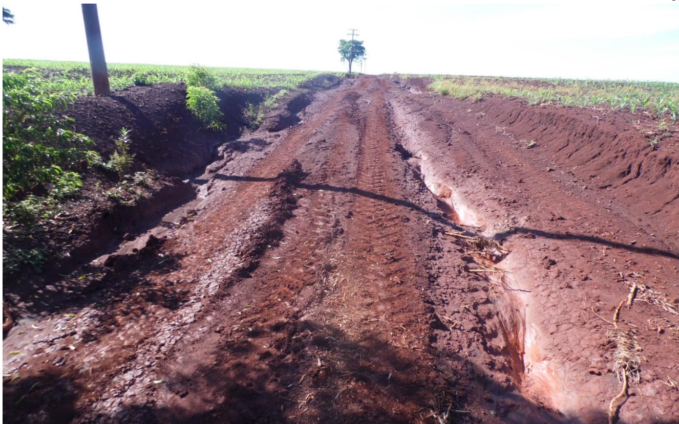
Imagem 09 – Durante os trabalhos periciais foi constatado que a estrada de terra que corta a propriedade não está em boas condições, o que dificulta o acesso e o escoamento da produção.
