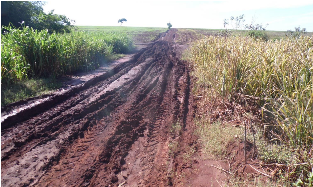
Imagem 01 – A estrada rural que dá acesso a propriedade - intransitável devido às fortes chuvas que caíram sobre a região, ao fundo, após a Água da Anhumas, o início da propriedade.
