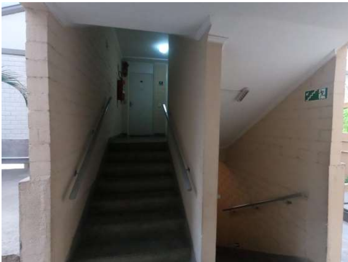
Foto 8. Escada de acesso.
