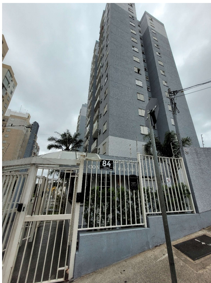
CONDOMÍNIO DO IMÓVEL AVALIANDO
