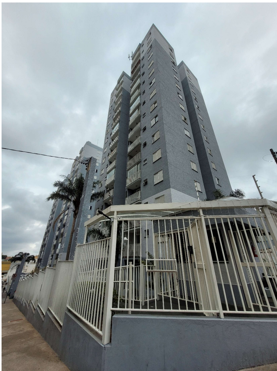
FOTO 02 – FACHADA DO CONDOMÍNIO DO IMÓVEL AVALIANDO
