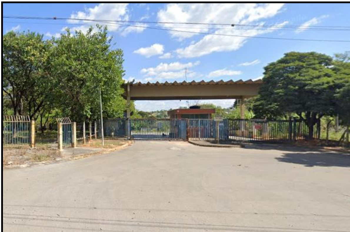
FOTO 01: Entrada do imóvel.
