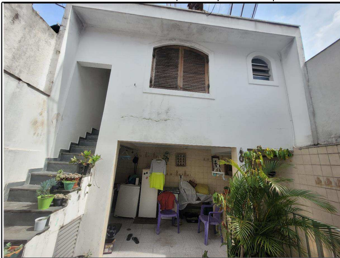
Foto 12 - Vista da edícula e do quarto no pavimento superior.
