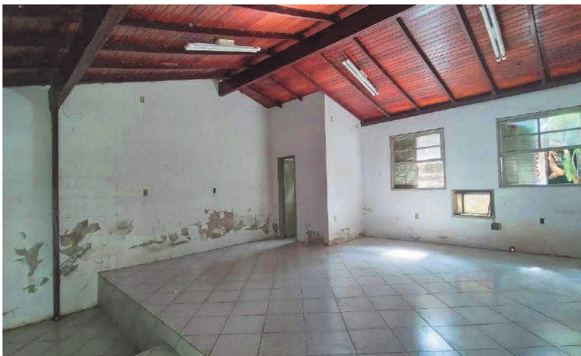
Casa de apoio – vista interna
