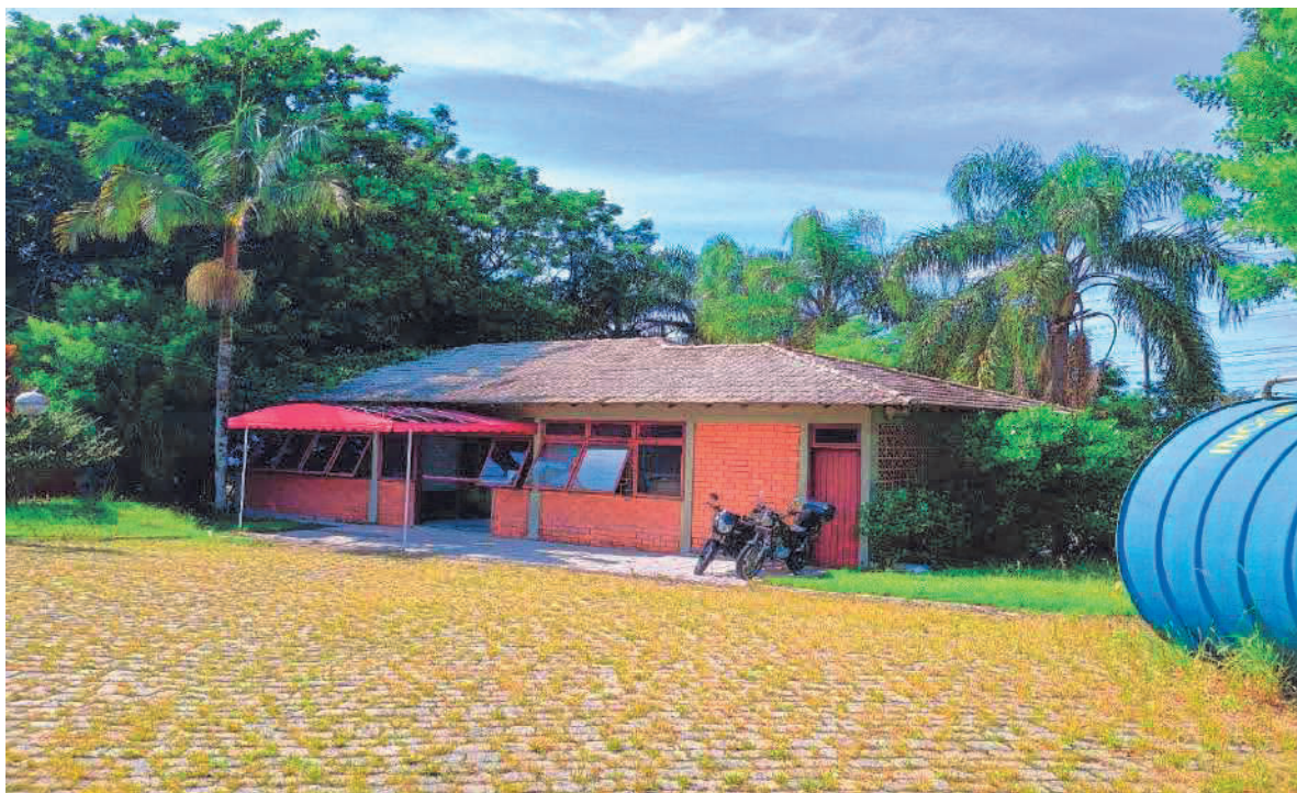
Bloco Administrativo – vista externa
