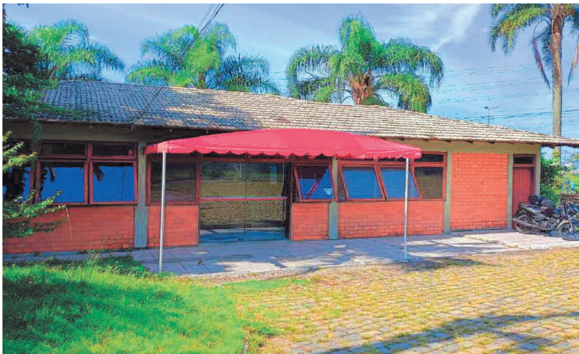
Bloco Administrativo – vista externa
