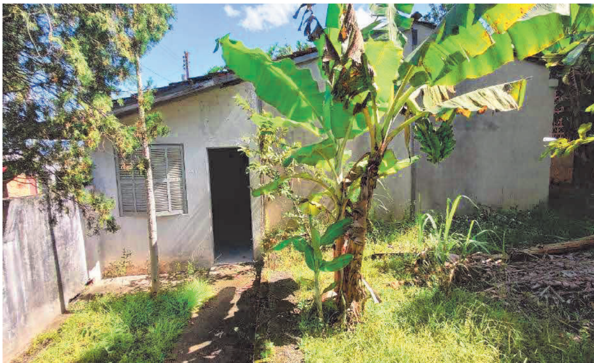
Casa de apoio – vista externa
