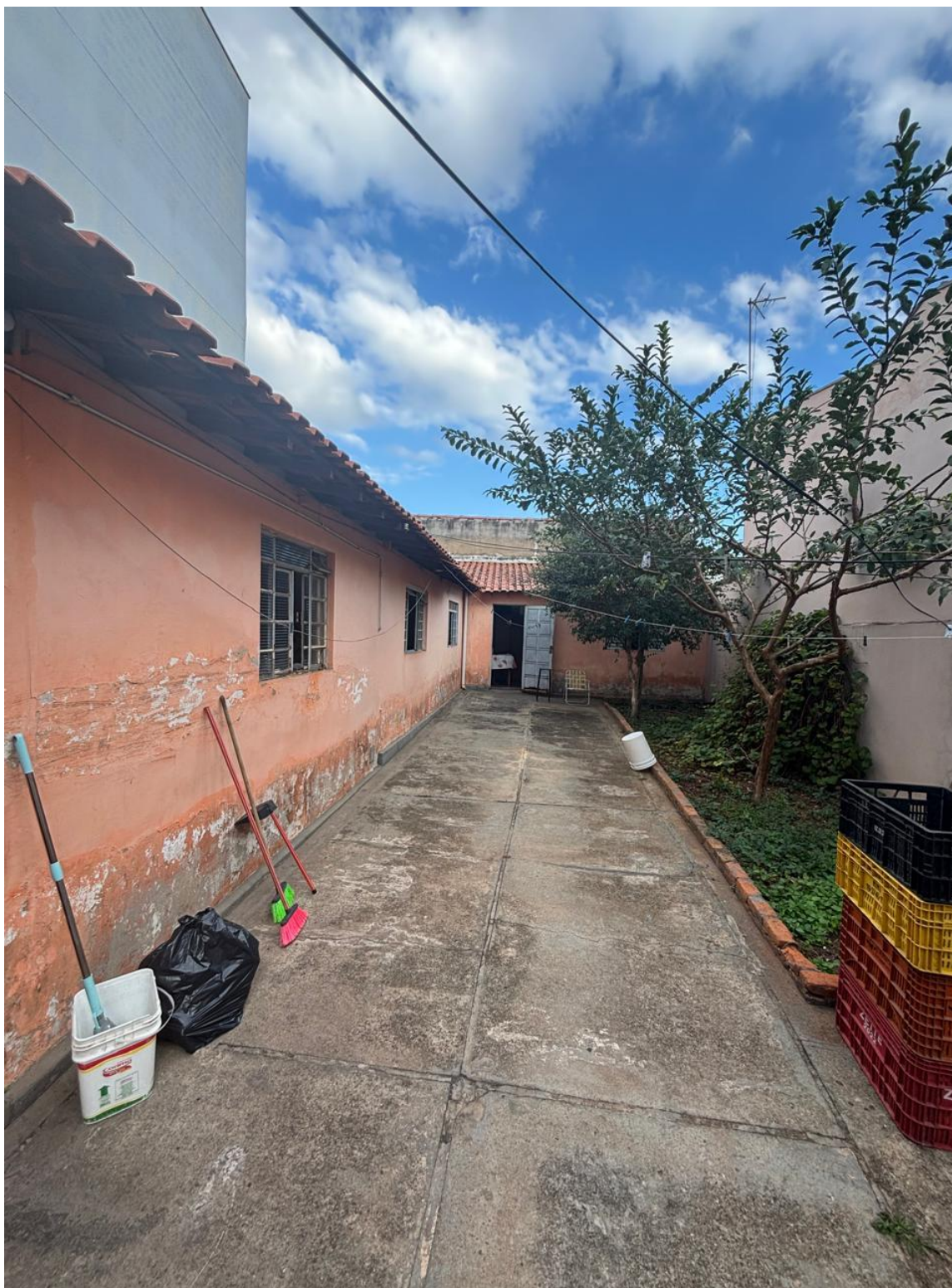
Vista do quintal e residência junto aos fundos
