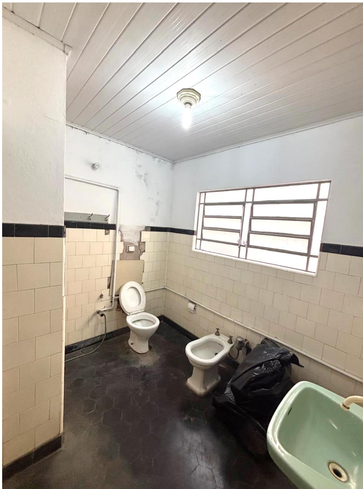
Banheiro do laboratório
