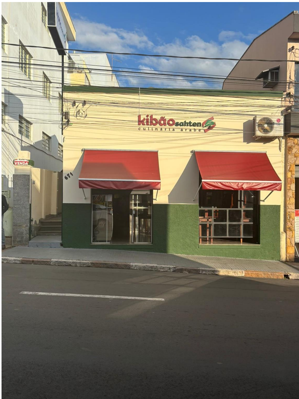
Vista frontal do imóvel avaliando
