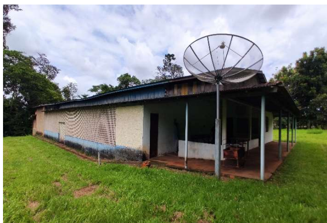
Foto 06: VISTA DO BARRACÃO.
