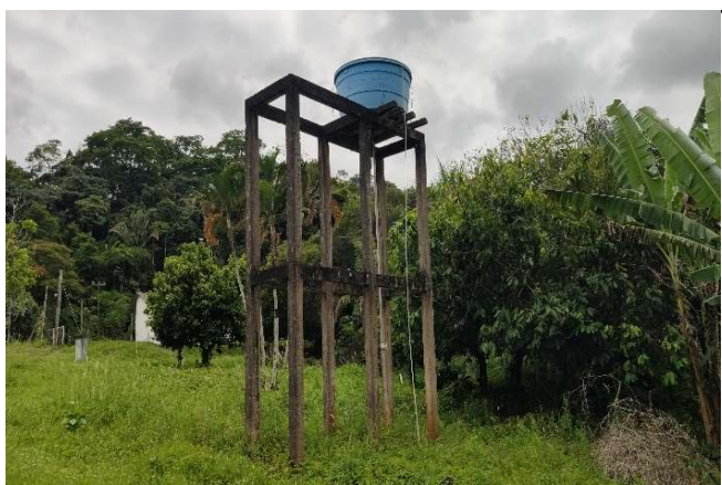
Foto 11: RESERVATÓRIO DE ÁGUA PRÓXIMO AO BARRACÃO.
