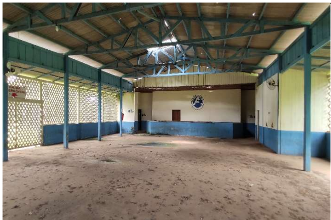
Foto 13: VISTA INTERNA DO BARRACÃO.
