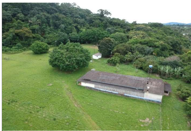
Foto 18: FOTO AÉREA APROXIMADA DO BARRACÃO.
