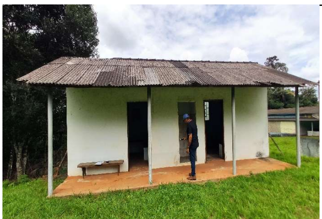
Foto 09: VISTA DO VESTIÁRIO.
