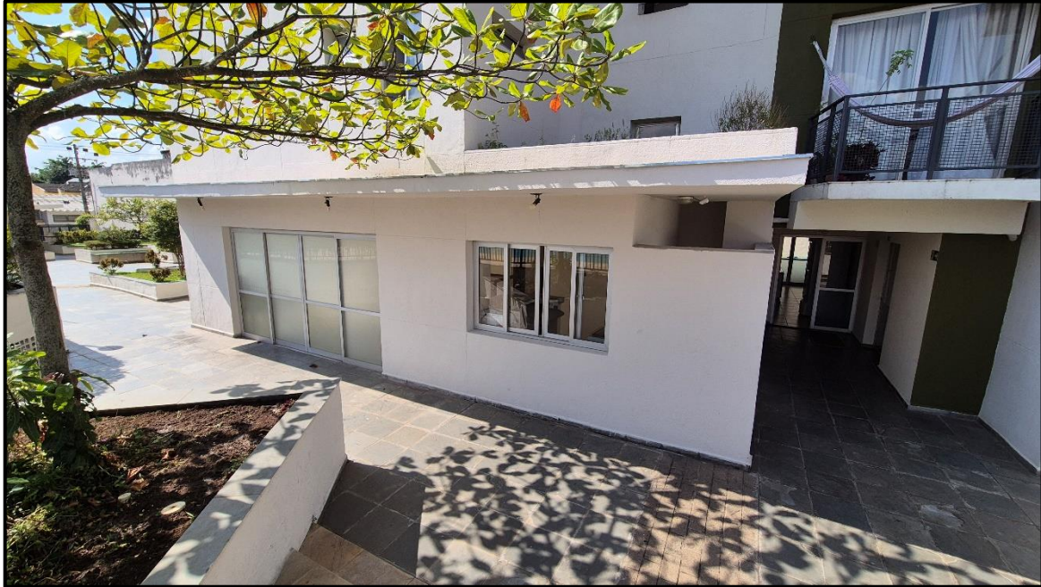
Ilustração 17: Vista interna das áreas comuns do empreendimento residencial denominado “CONDOMÍNIO GREEN PEACE” – Vista externa do salão de festas no térreo
