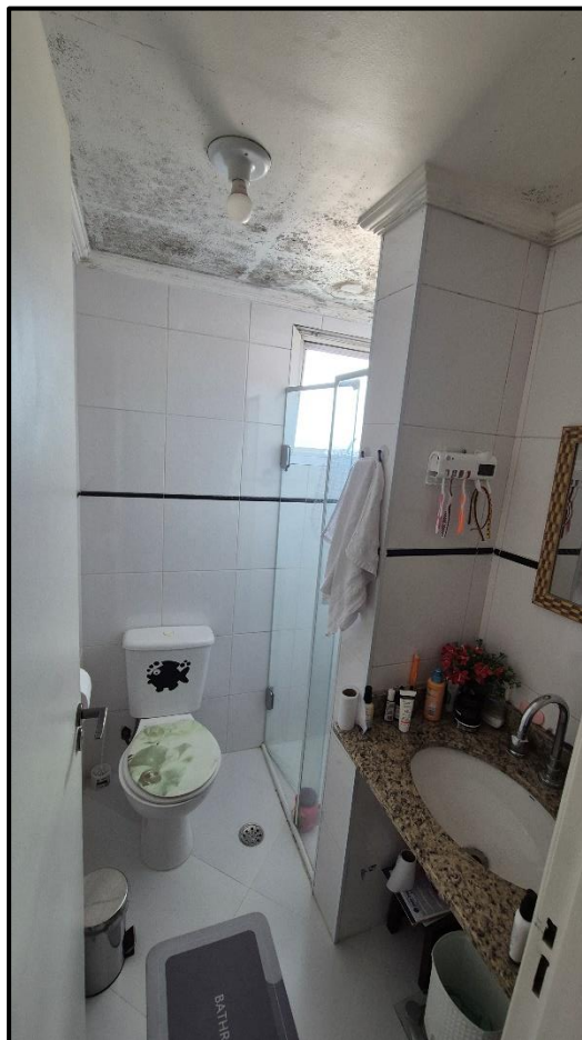
Ilustração 34: Unidade privativa análoga ao avaliando – Banheiro
