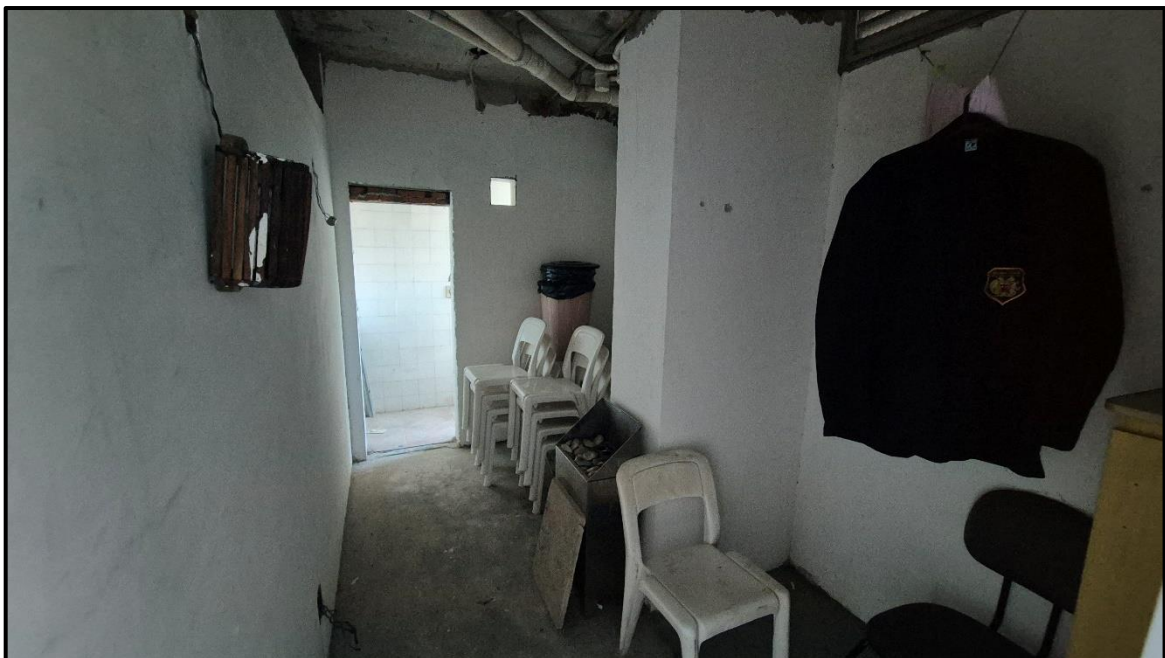
Ilustração 24: Vista interna das áreas comuns do empreendimento residencial denominado “CONDOMÍNIO GREEN PEACE” – Área técnica/vestiários de funcionários
