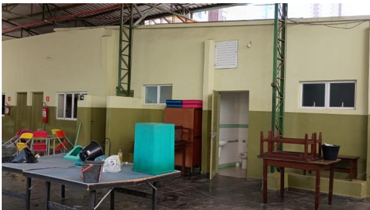
FOTO Nº 14: Vista dos fundos da edificação da foto 10, que possui salas de aula e sanitários.
