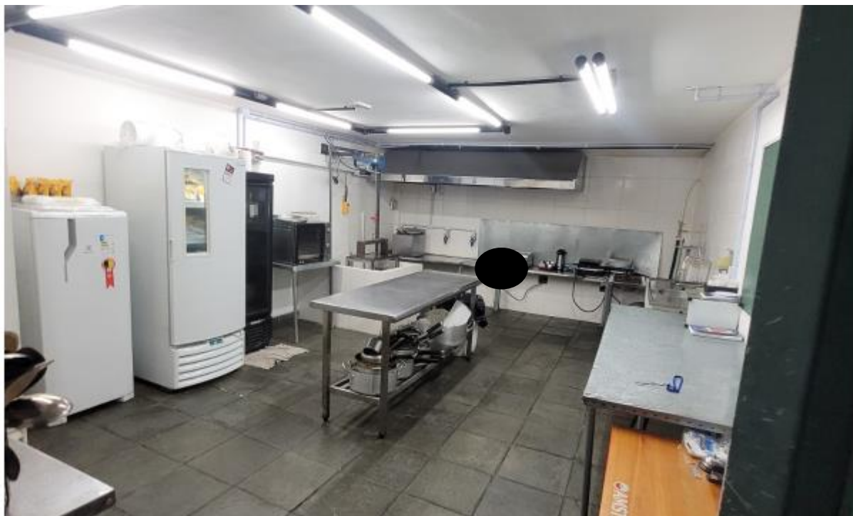
FOTO Nº 11: Vista da cozinha do piso superior.
