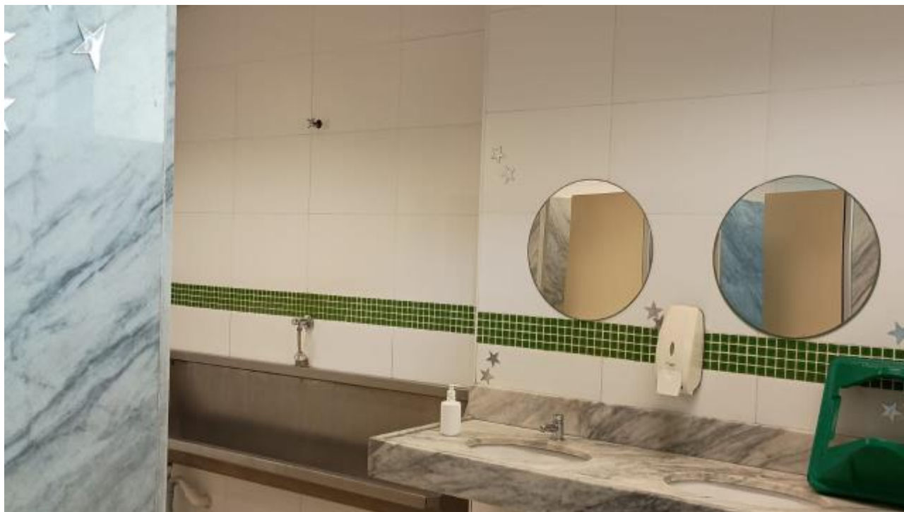
FOTO Nº 15: Vista do sanitário.
