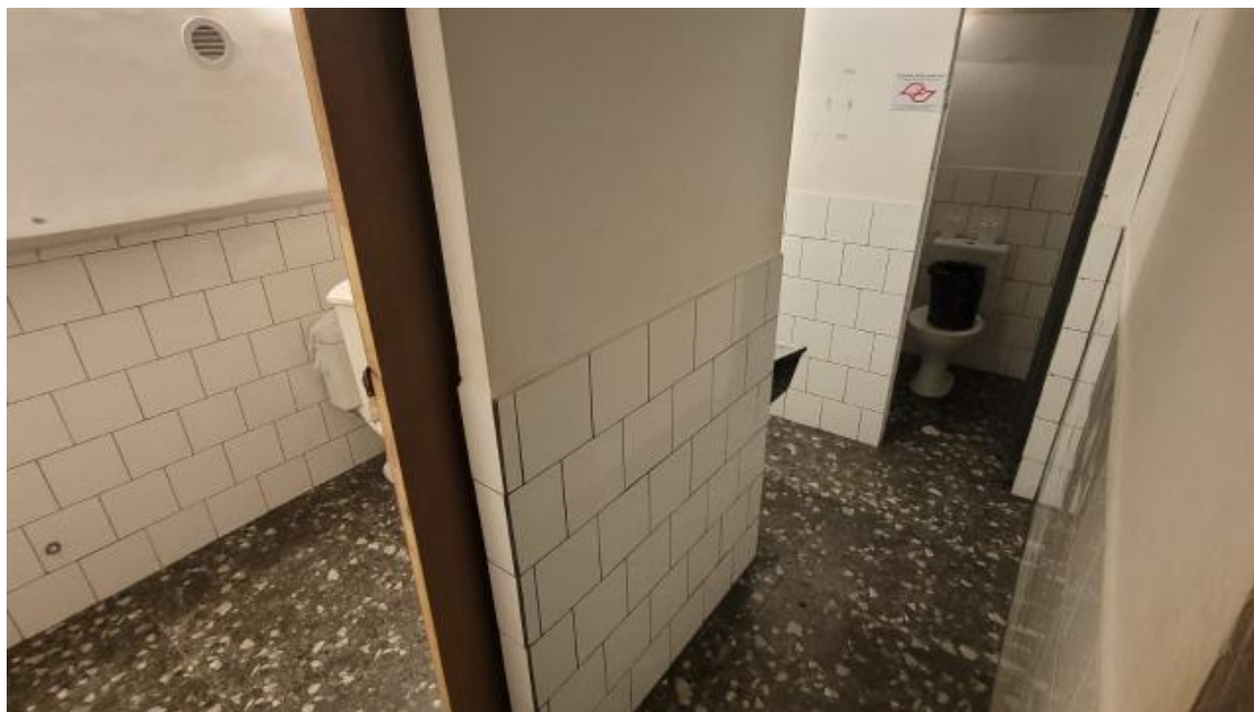
FOTO Nº 7: Vista interna do sanitário.
