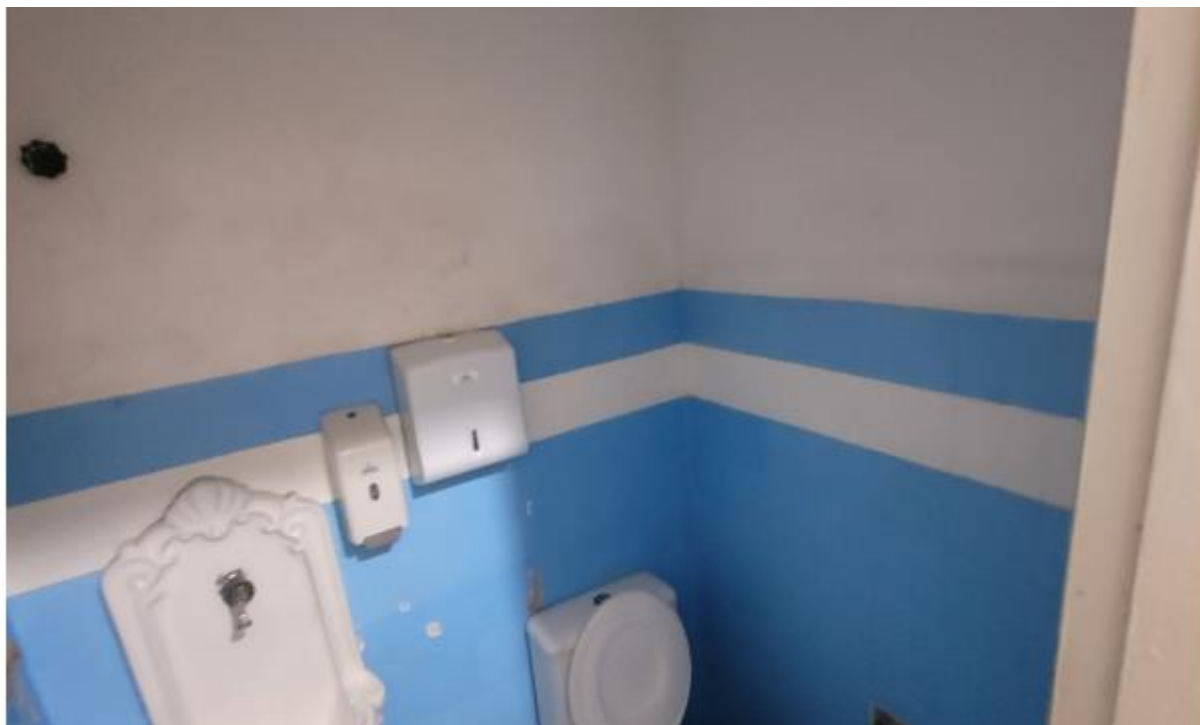
FOTO Nº 13: Vista do banheiro no térreo.
