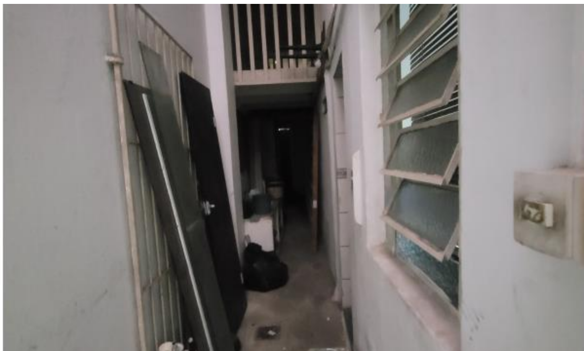
FOTO Nº 14: Vista dos fundos da edificação.
