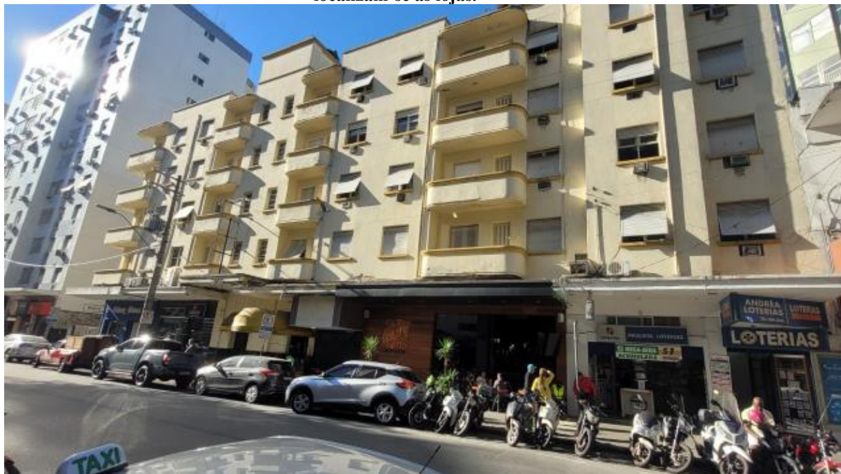
FOTO Nº 1: Vista geral da fachada do imóvel. Nos andares funciona o Hotel Ritz, e no térreo localizam-se as lojas.
