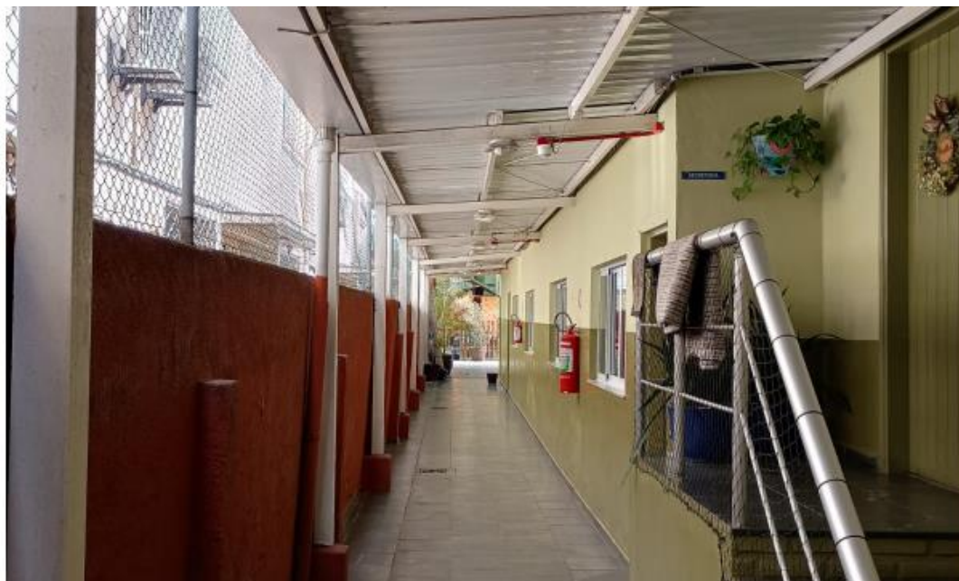
FOTO Nº 10: Vista do corredor, onde vemos a direita, a parte que foi construída posteriormente, pelos locatários.
