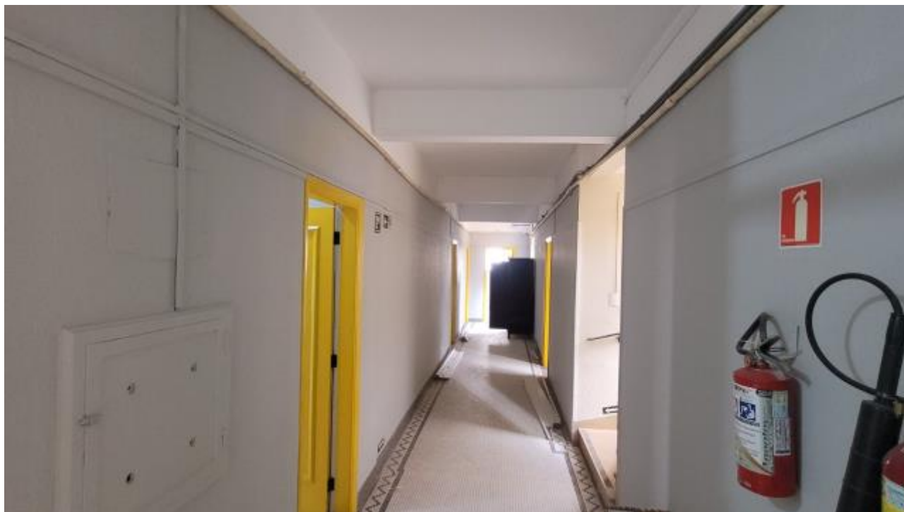
FOTO Nº 25: Vista do corredor de distribuição do 2º pavimento.
