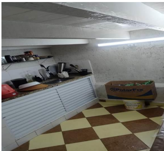
Foto 5: Porão do imóvel
