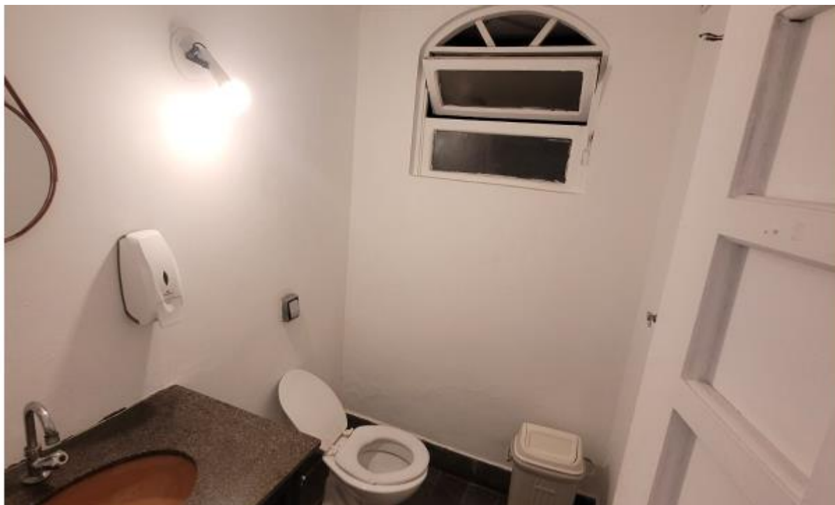
FOTO Nº 13: Vista do banheiro do piso superior.
