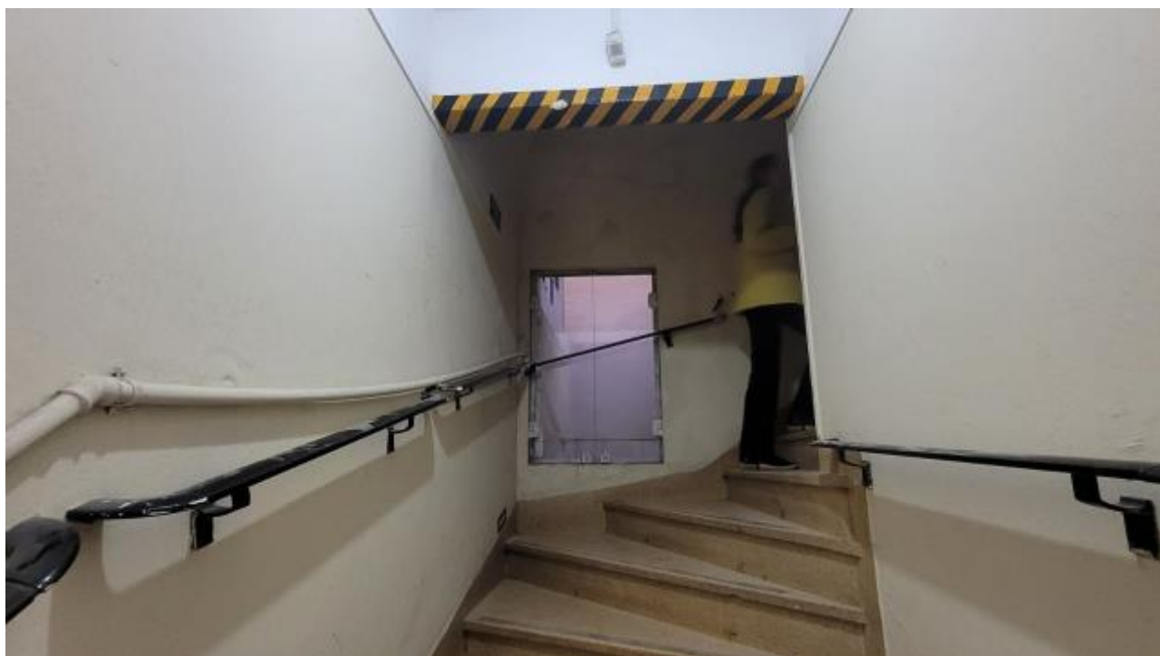
FOTO Nº 15: Vista da escada de acesso aos andares.
