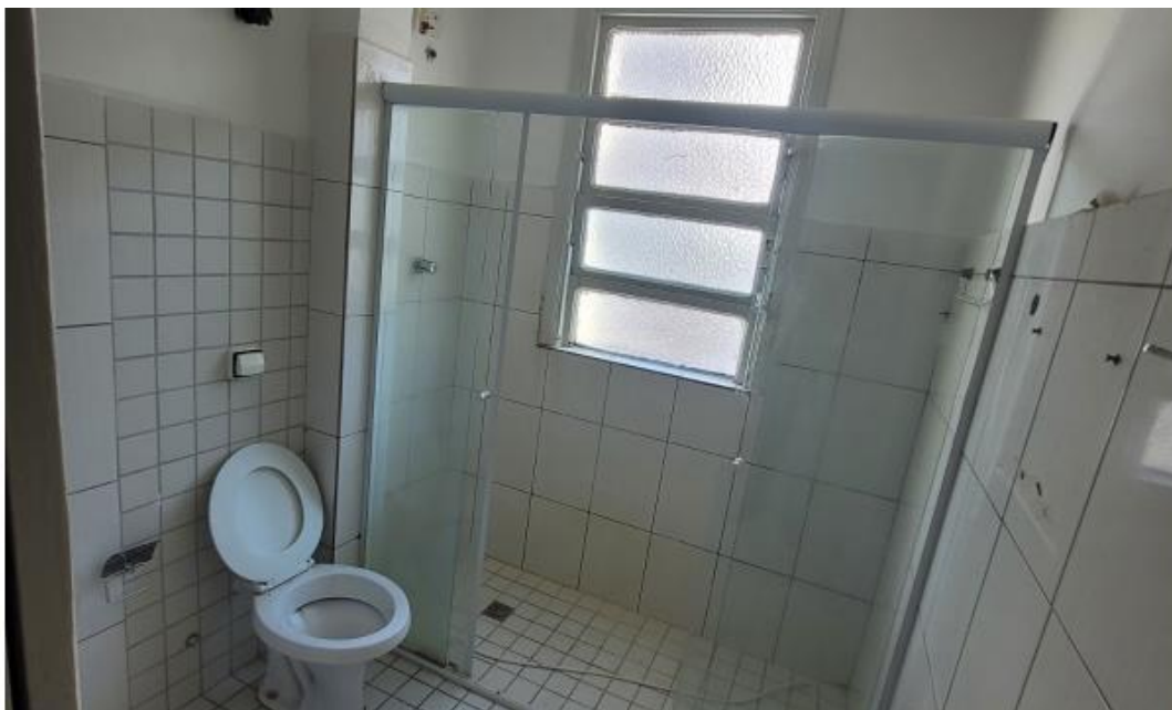
FOTO Nº 27: Vista do banheiro.
