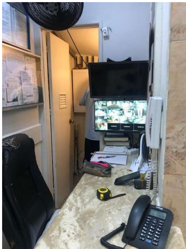
Figura 14 – Vista do balcão de zeladoria e sistema de câmeras de segurança.
