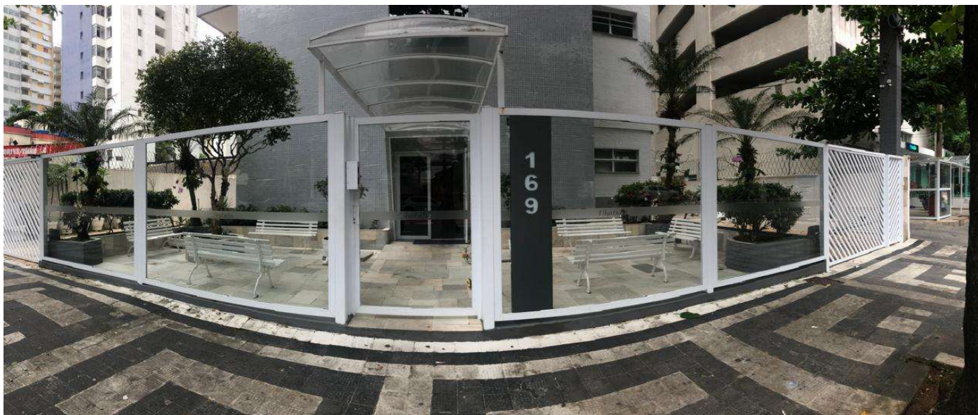
Figura 11 – Vista da entrada de pedestres térreo do Edifício Avaliado.
