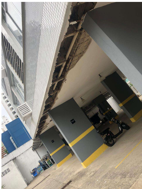
Figuras 38 e 39 – Vistas pavimento térreo, forro aberto revelando estruturas e ferragens expostas do Condomínio Ubatuba.
