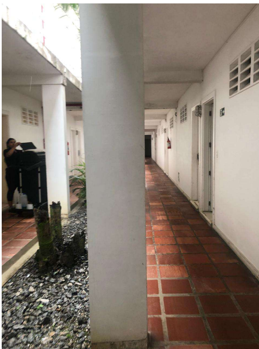
Figura 21 – Vista corredor onde se encontra o apartamento avaliado nº126.
