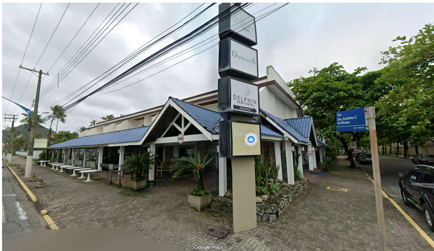
Figura 4 – Imagem Frente do Edifício esquina das Avenida Miguel Estefno e Rua Des. Euclides Cunha da Silveira. Fonte: Google Maps.
