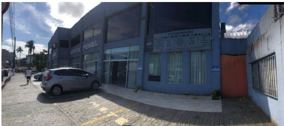
Figura 16– Vista da parte frontal, extremidade oposta a imagem anterior. Entrada serviços.
