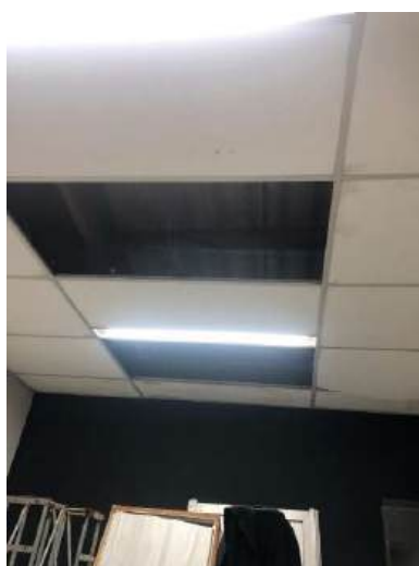
Figura 26 - Vista detalhe forros espaço de apoio técnico posterior a Salão principal.
