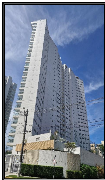
Figura 5 – Vista fundo do Edifício
