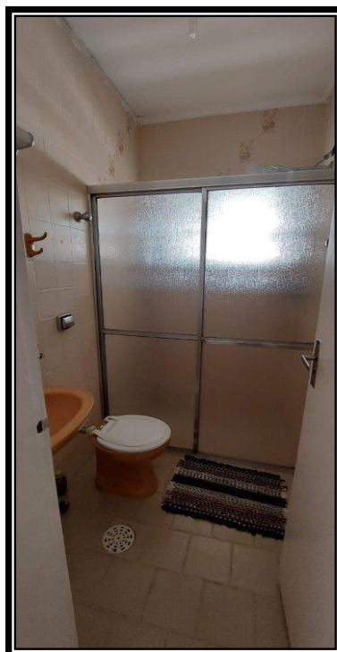
Figura 13 – Banheiro – apto similar
