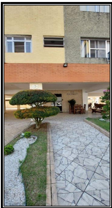
Figura 5 – Entrada do Edifício
