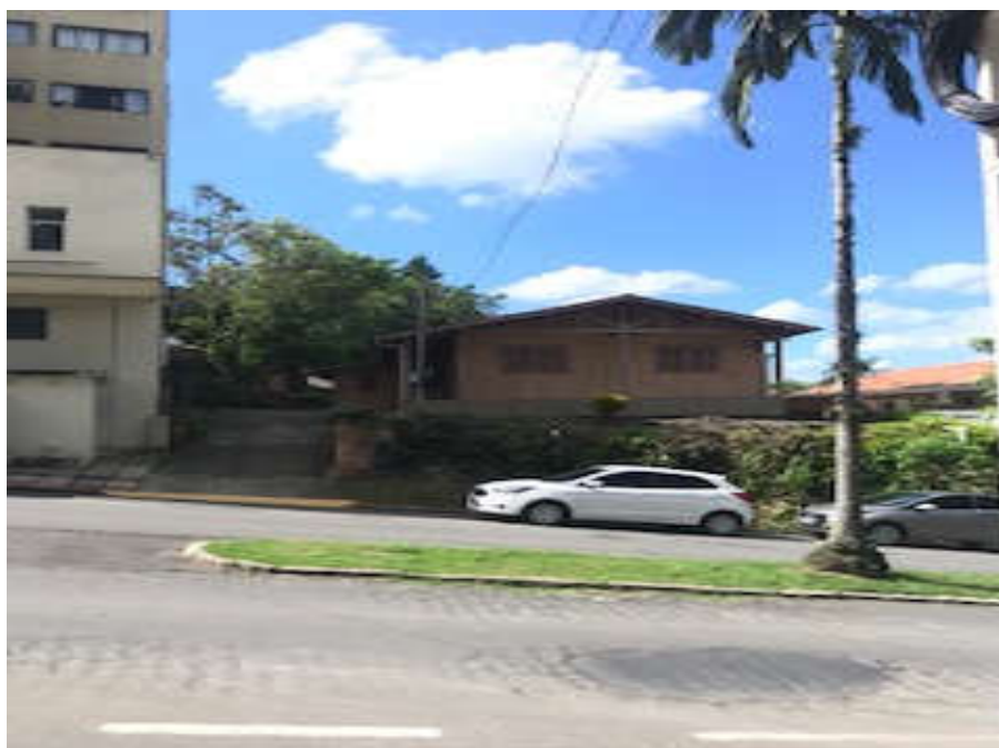
IMAGEM nº 1 - DE FRENTE DO IMÓVEL AVALIADO
