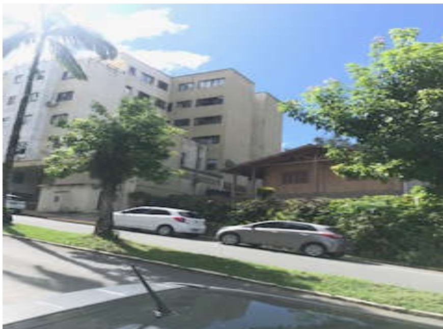
IMAGEM nº 3 – DO imóvel avaliado E O IMÓVEL DO LADO ESQUERDO
