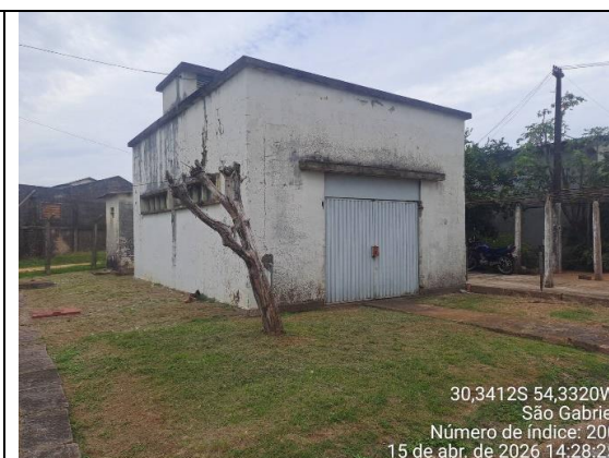
Foto 6 – Prédio Casa do Grupo Gerador/Refeitório
