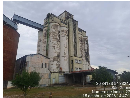
Foto 14– Central de Beneficiamento e Silos de Concreto (10 unidades)
