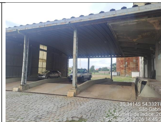
Foto 12 – Moegas Rodoviárias (I, II e III)
