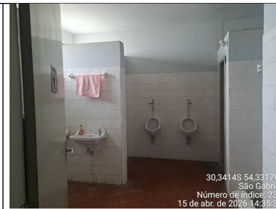
Foto 9 – Vista Interna do Vestiário/Banheiro
