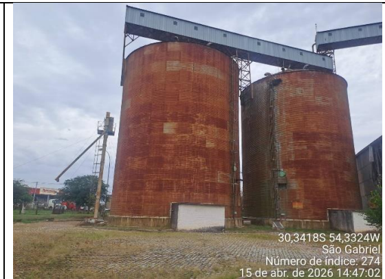
Foto 15 – Silos Metálicos e Passarela
