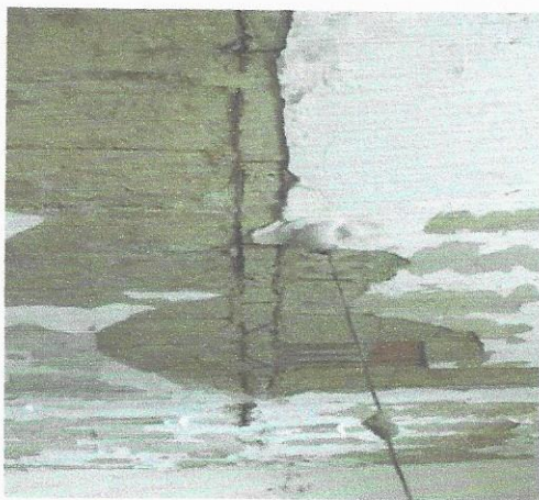
Forro em Lage interno com ferragens da viga exposta e com buracos.
