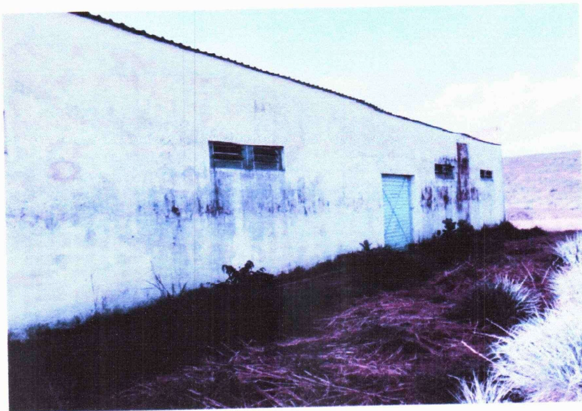
Foto 02: parte externa do prédio maior.
