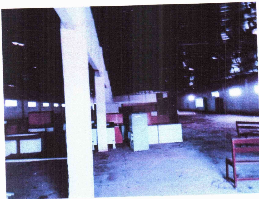
foto 06: parte interna do prédio maior: piso industrial.
