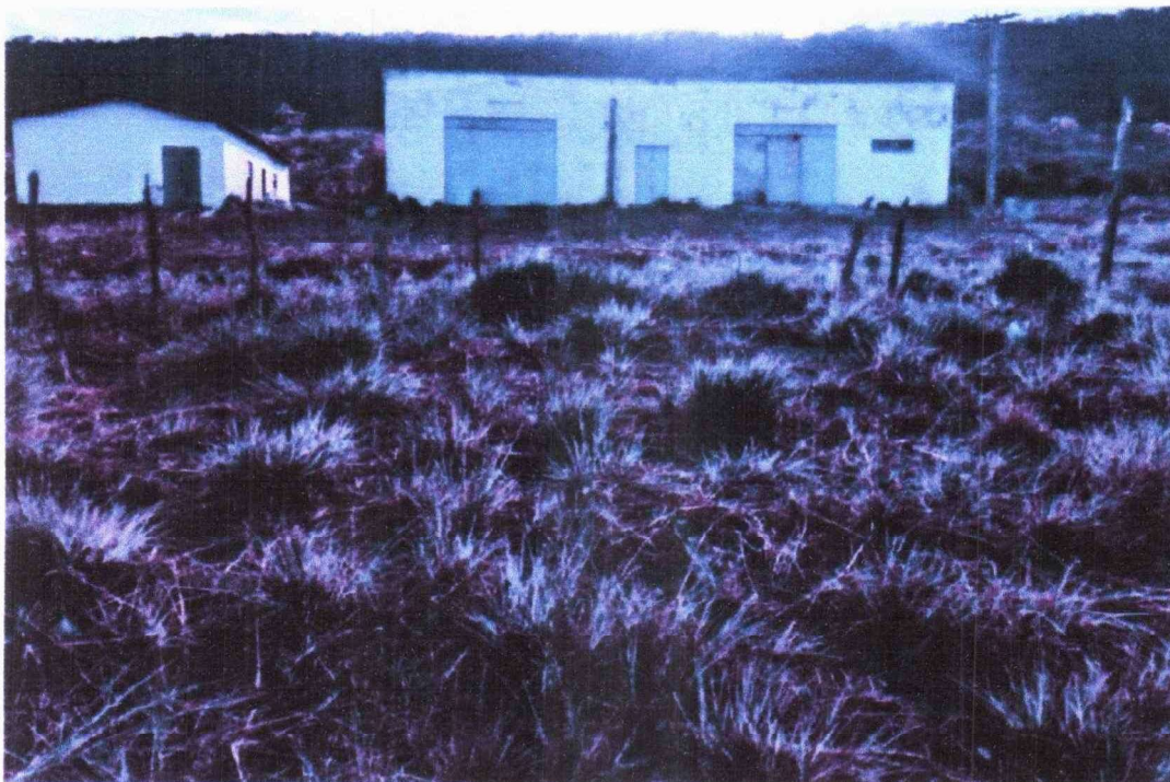
Foto 01: frente dos imóveis onde funcionava a fábrica
