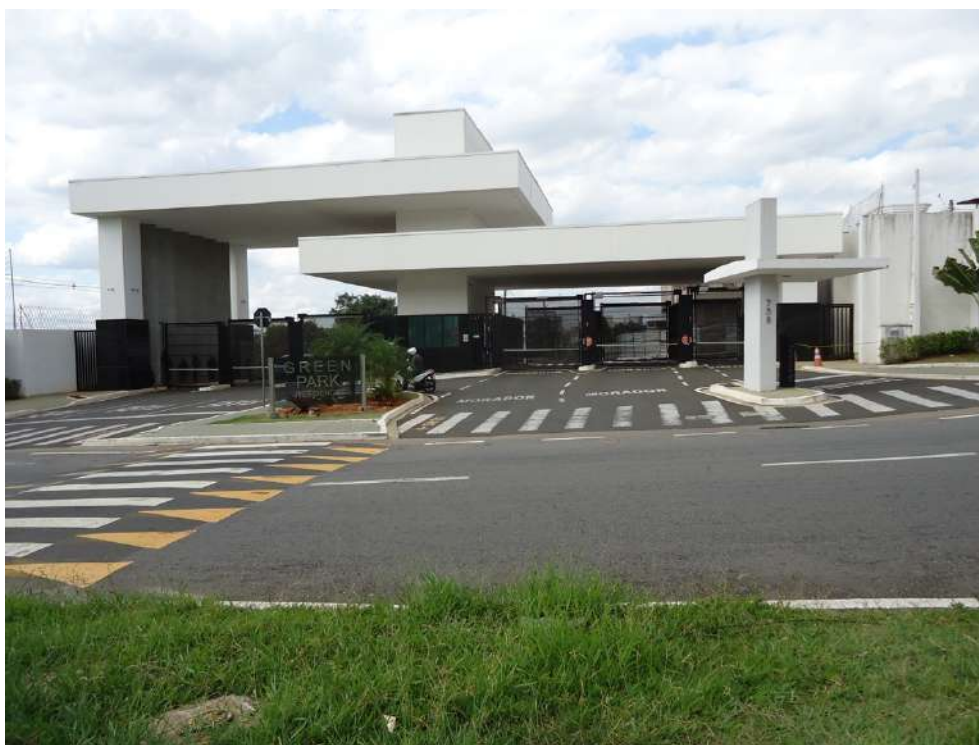
Fachada do imóvel avaliando
