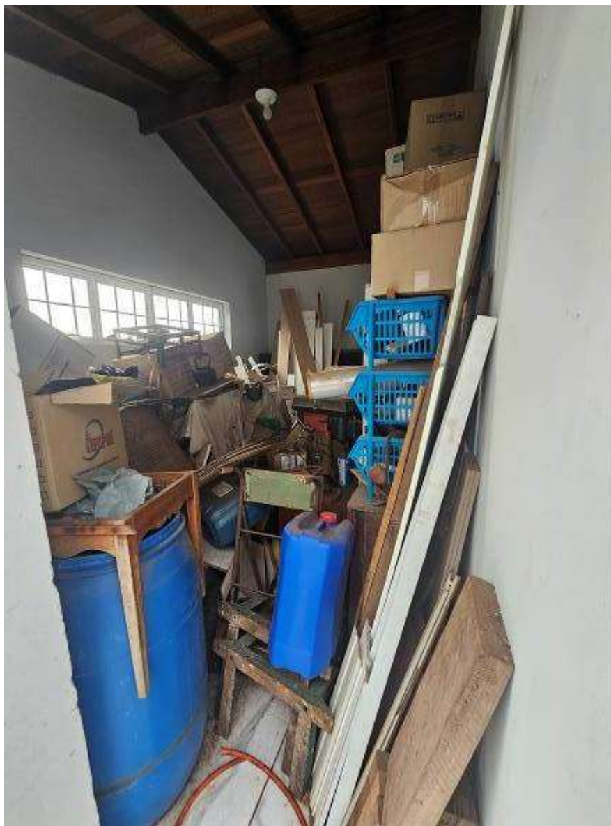
VISTA DE CÔMODO ANEXO À EDIFICAÇÃO 01.
