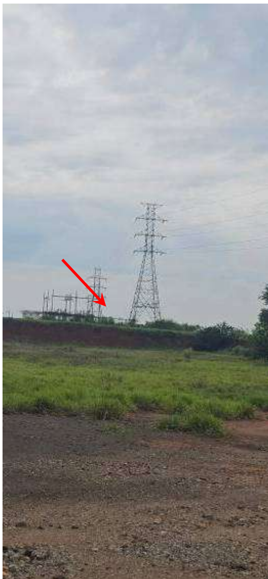
DETALHE DO LOCAL DA FAIXA DE SERVIDÃO, COM A INSTALAÇÃO DAS TORRES.
