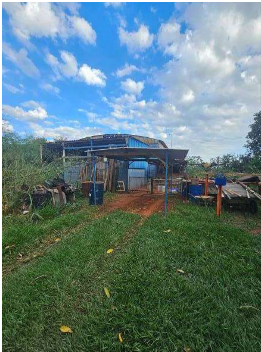
VISTA DO GALPÃO E DA COBERTURA 04.
