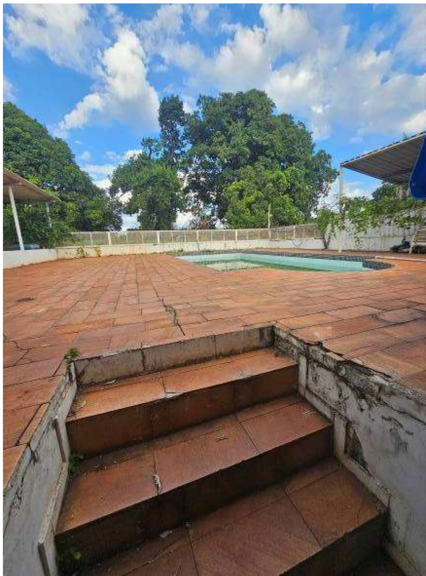
VISTA DO ACESSO À PISCINA.
