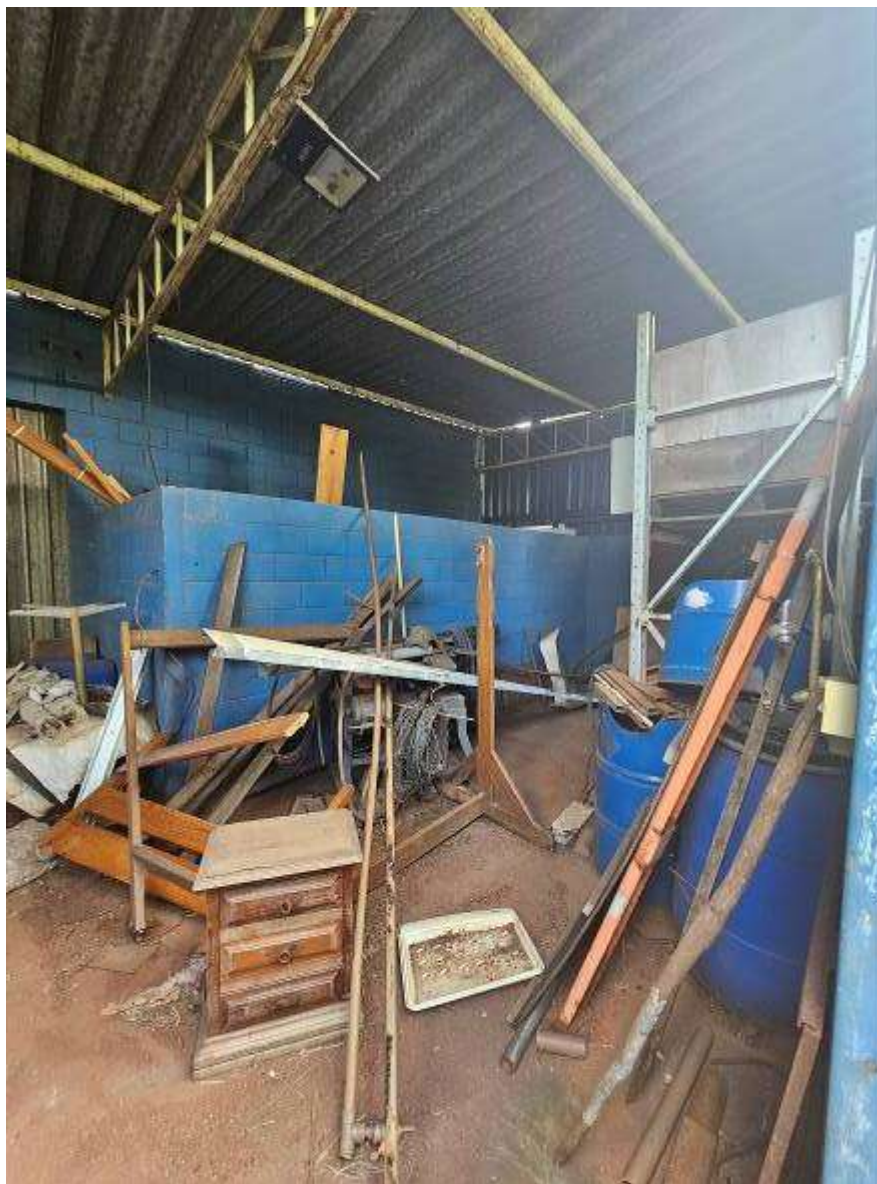
VISTA PARCIAL DO GALPÃO E DA COBERTURA 04.
