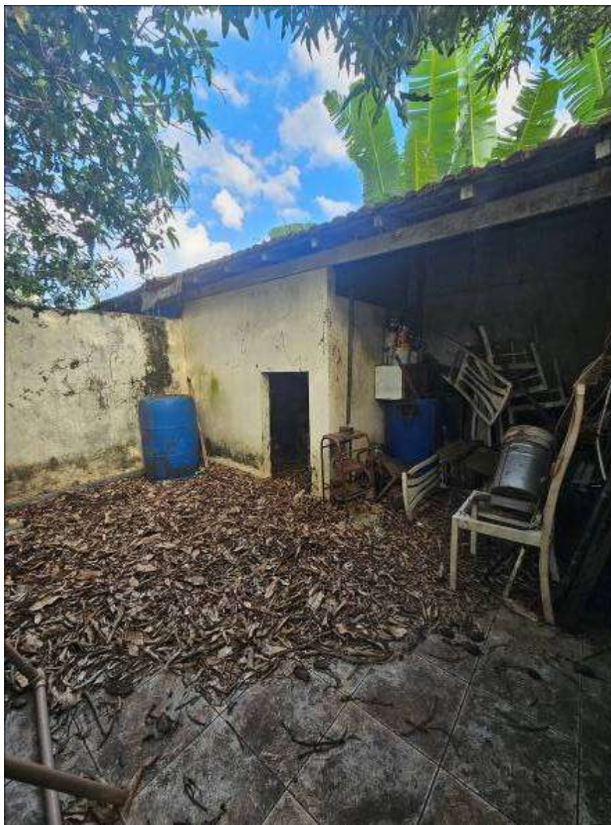
VISTA DA EDIFICAÇÃO 03.
