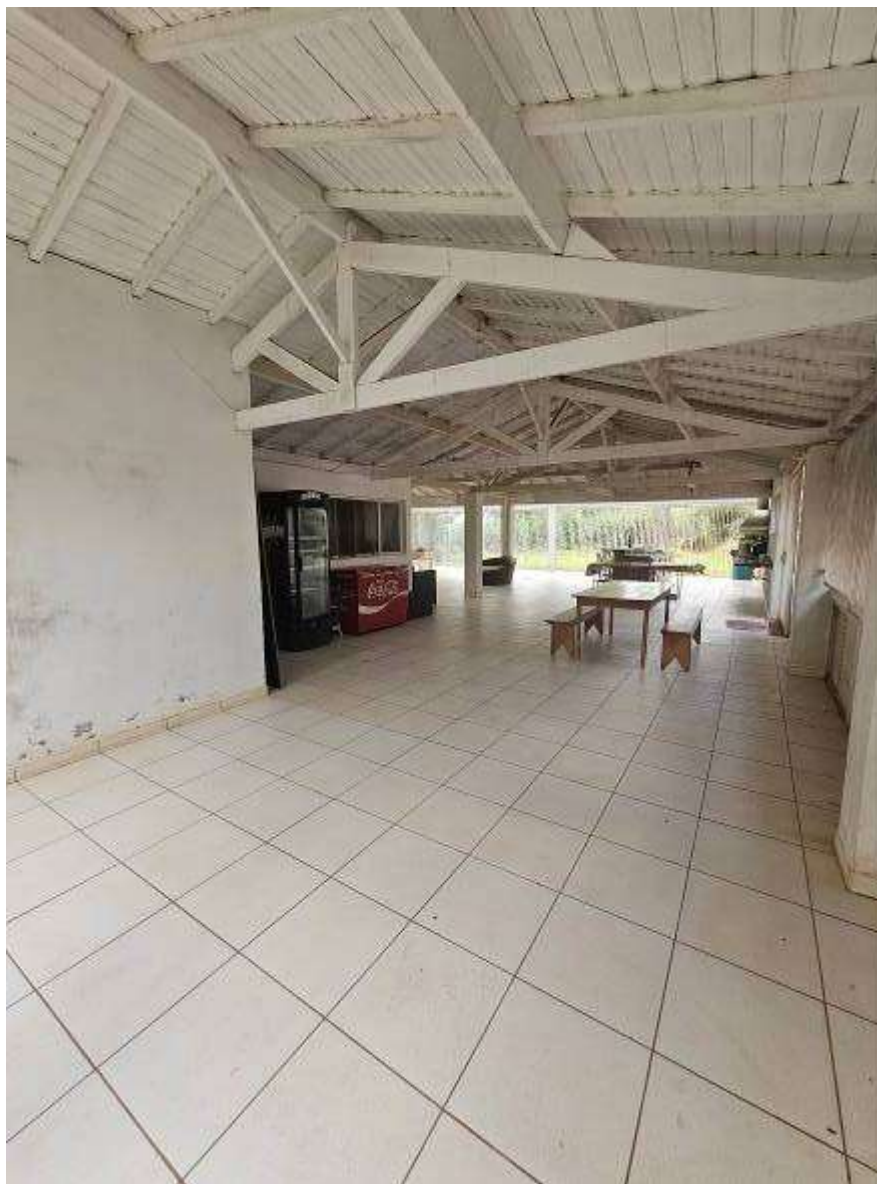
VISTA DA COBERTURA 01.
