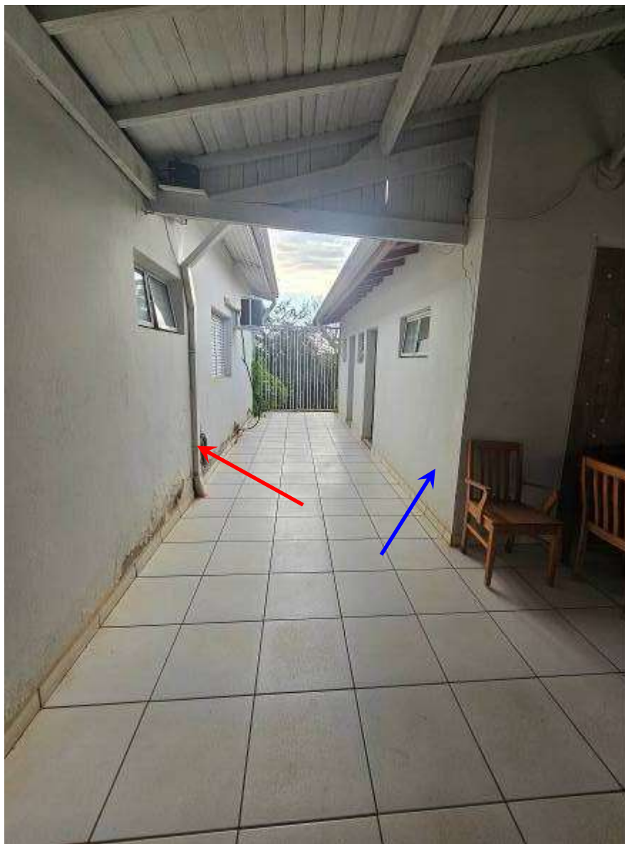
VISTA DAS EDIFICAÇÕES 01 (SETA VERMELHA) E 02 (SETA AZUL).
