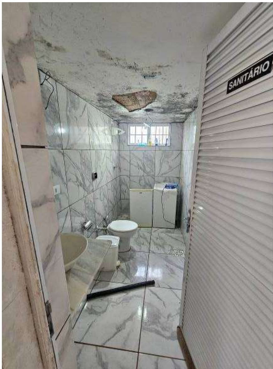
BANHEIRO ANEXO À COBERTURA 01.
