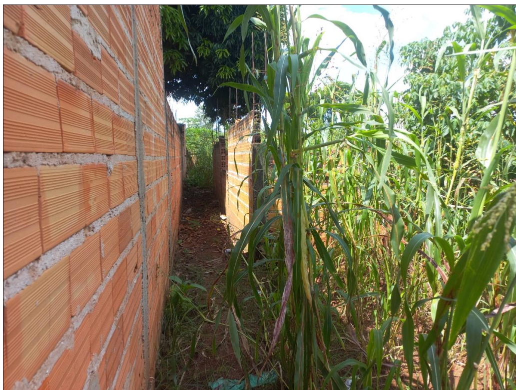
Foto 4: Recuo de construção inacabada, (construção não agrega valor ao lote)
