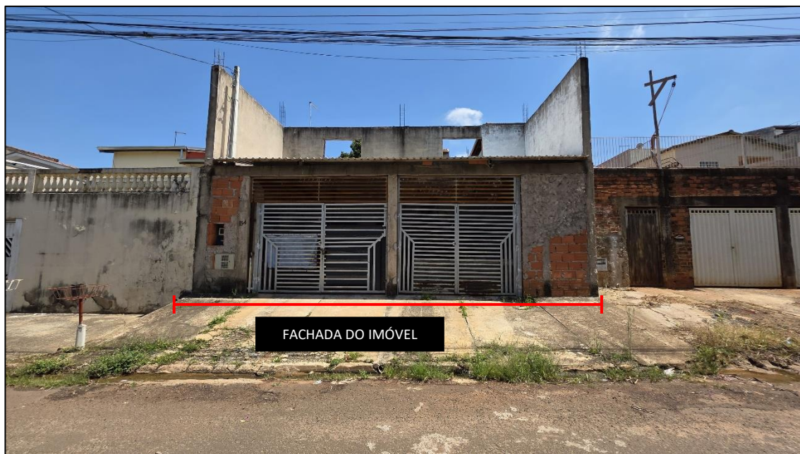
Imagem 07: Fachada do imóvel.
