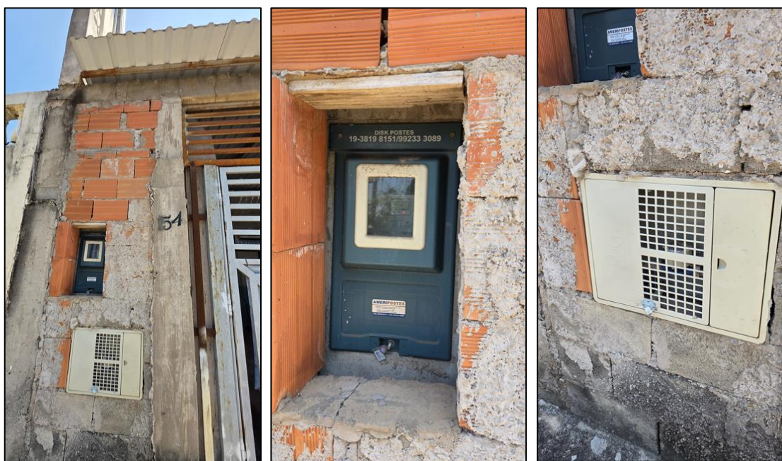
Imagem 15: Fachada lateral esquerda parcialmente rebocada. Presença de poste de energia e de relógio medidor de água.
