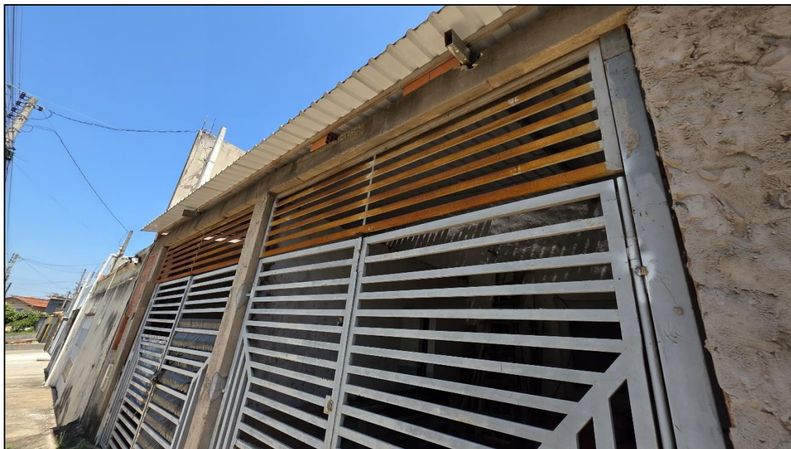
Imagem 14: Telhas apoiadas sobre estrutura metálica.
