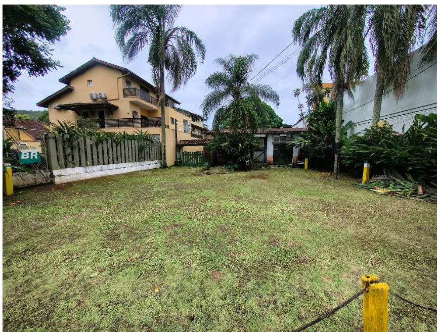
Figura 1 - vista da fachada do imóvel avaliando
