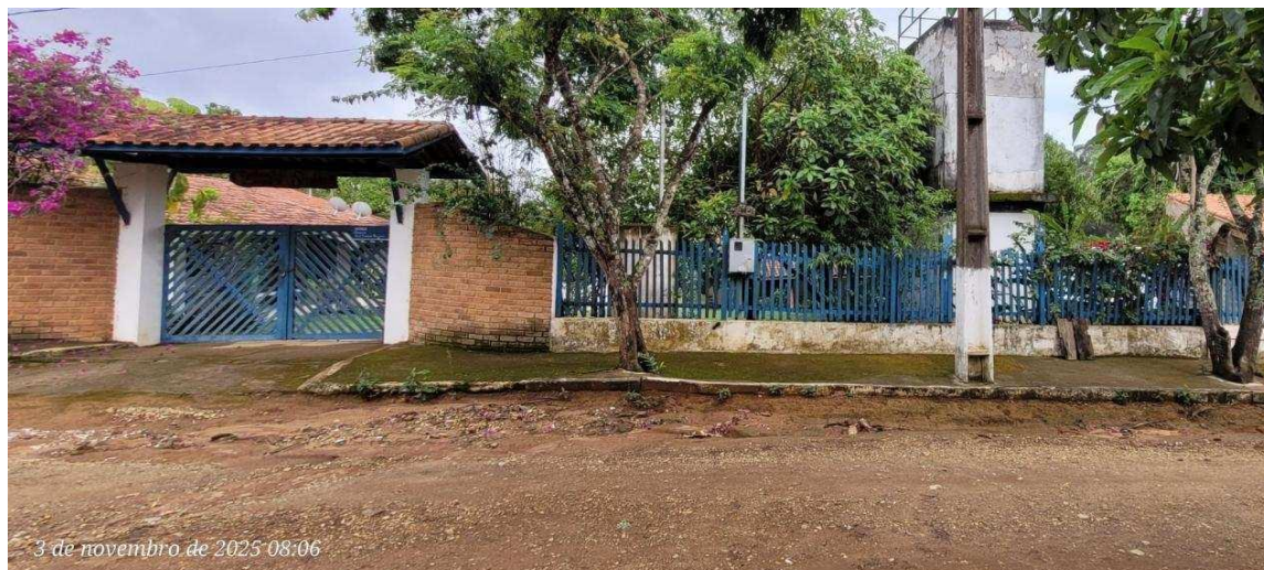
Vista do Imóvel Avaliando
