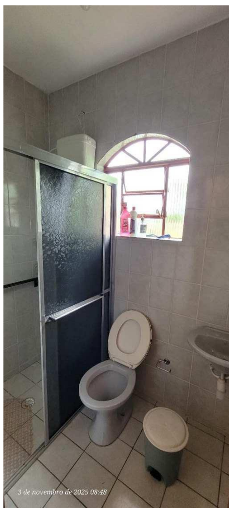
Foto 12 – Detalhe do Banheiro Social do Imóvel Avaliando
