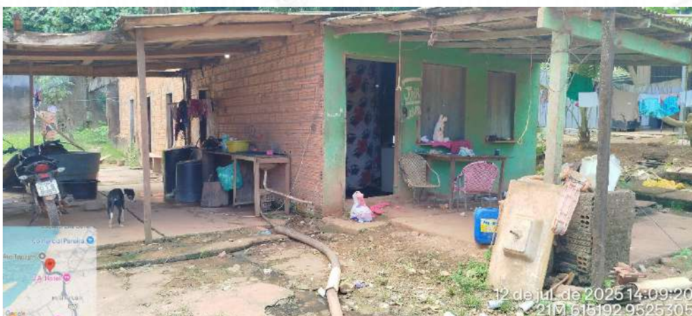
Foto 4 - Construções de edificações irregulares
