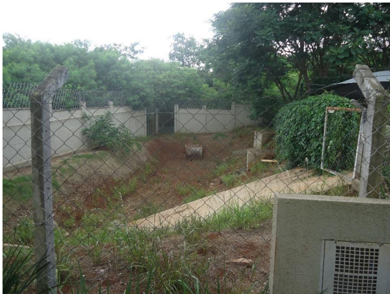
Local para captação de águas pluviais.
