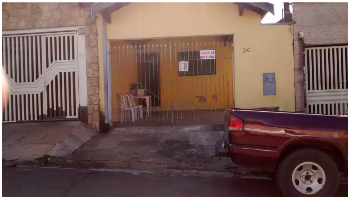
FOTO n.01 – Fachada do imóvel avaliando.
