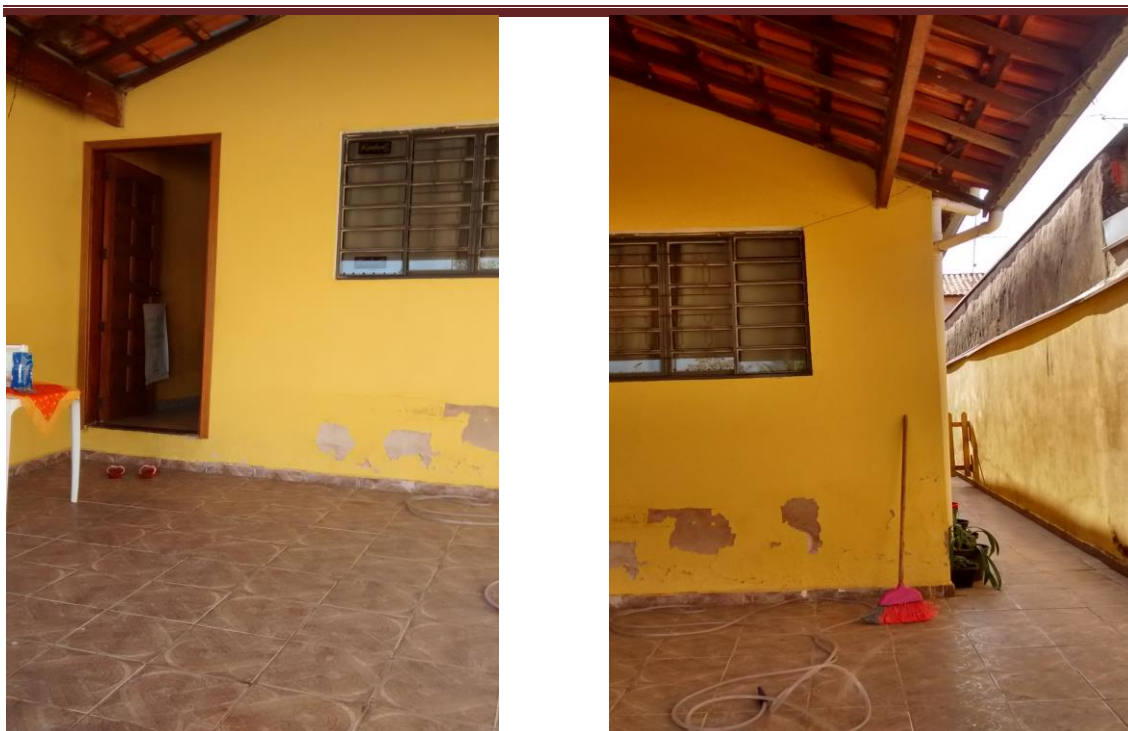
FOTOS n. 02 e 03 – Garagem / Corredor externo
