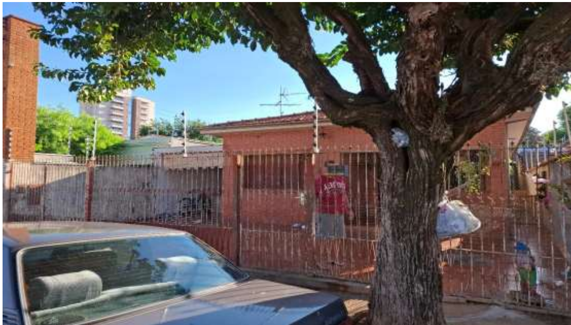
Foto Nº 01: Mostrando a frente do imóvel da Rua Diogenes Muniz Barreto.
