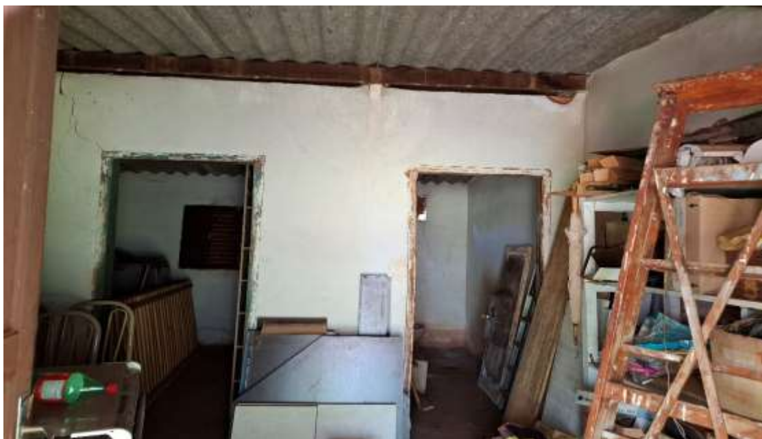
Foto Nº 13: Mostrando aspectos internos da edificação.
