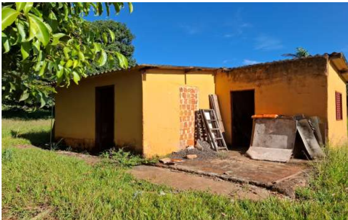
Foto Nº 12: Mostrando aspectos da edificação.
