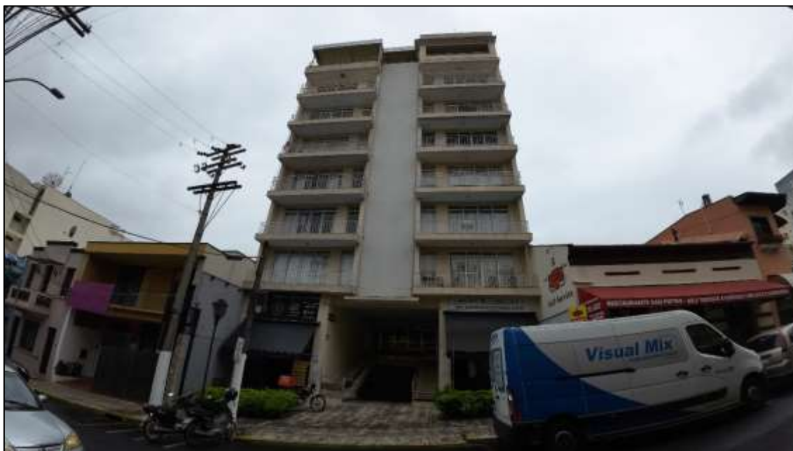
Figura 3 - Vista externa do Edifício Sinharinha
