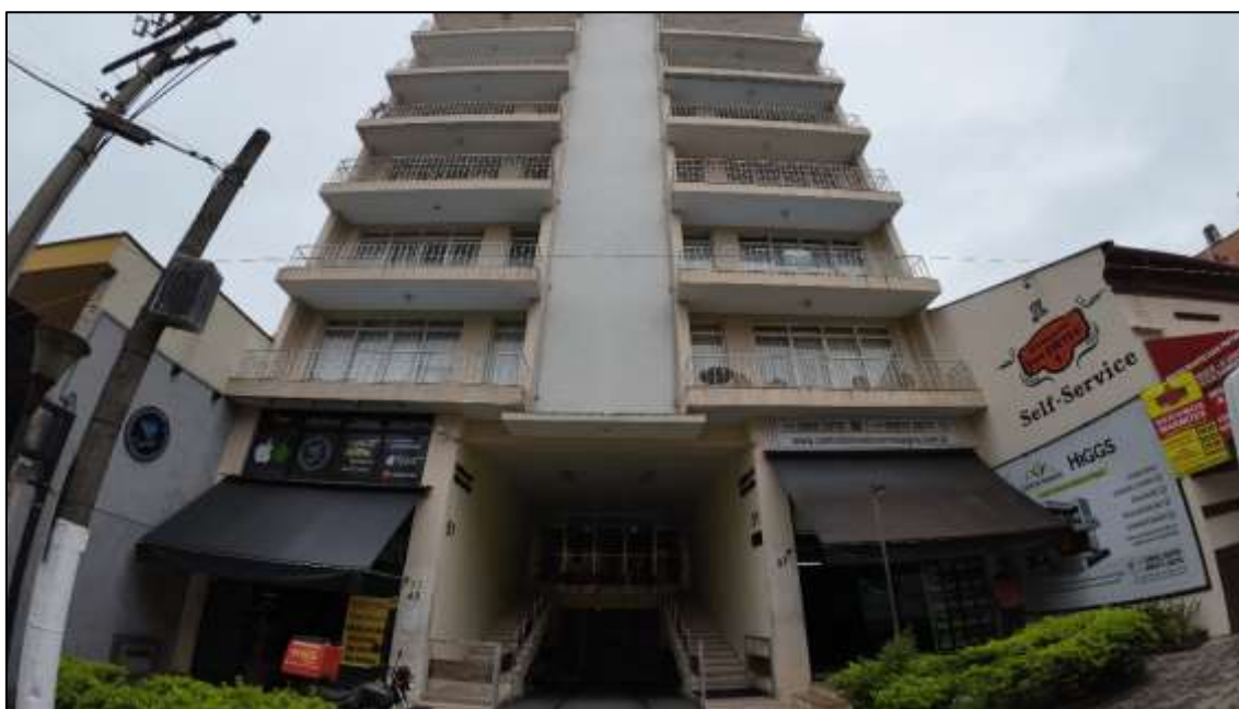
Figura 4 - Vista externa do Edifício Sinharinha
