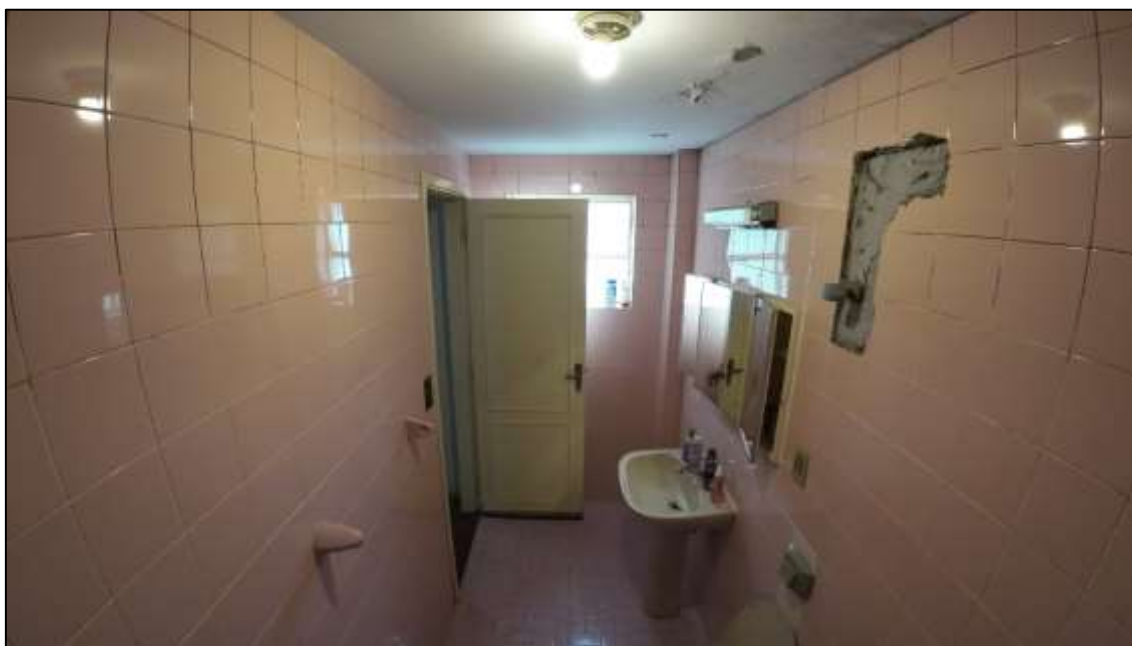
Figura 10 - Vista interna do apartamento 52, visão do Banheiro 1
