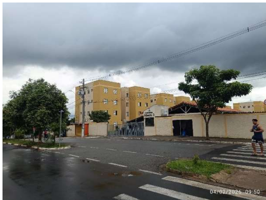
Vista Frente Condomínio
