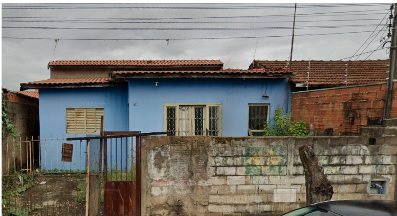
Foto 1: Fachada do imóvel objeto desta perícia.
