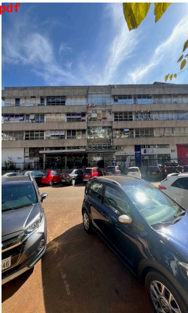
Foto 1: FACHADA DO PRÉDIO
