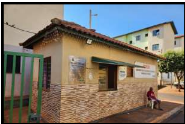
PORTARIA CONDOMÍNIO RESIDENCIAL ARAGÃO II
